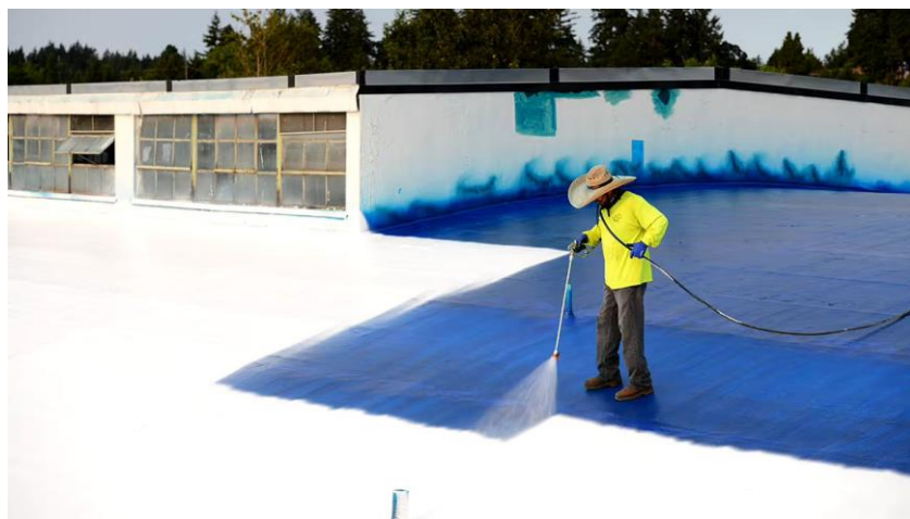
Slika 22. Nanošenje akrilne izolacije pomoću spreja
