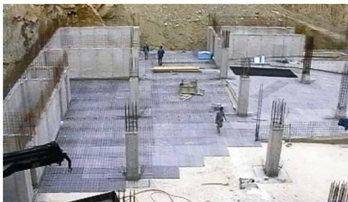
Slika 38. Membrana kao hidroizolacija temeljne ploče
