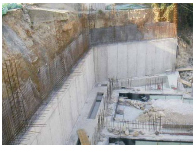
Slika 37. Postavljanje Voltex-a u jednostranu oplatu
