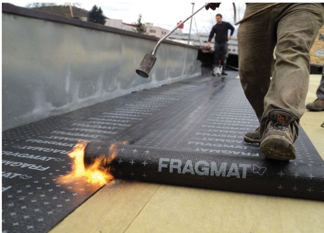
Slika 10. Spajanje preklopa toplinom
