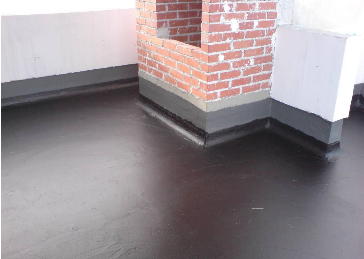
Slika 7. Bitumenski premaz
