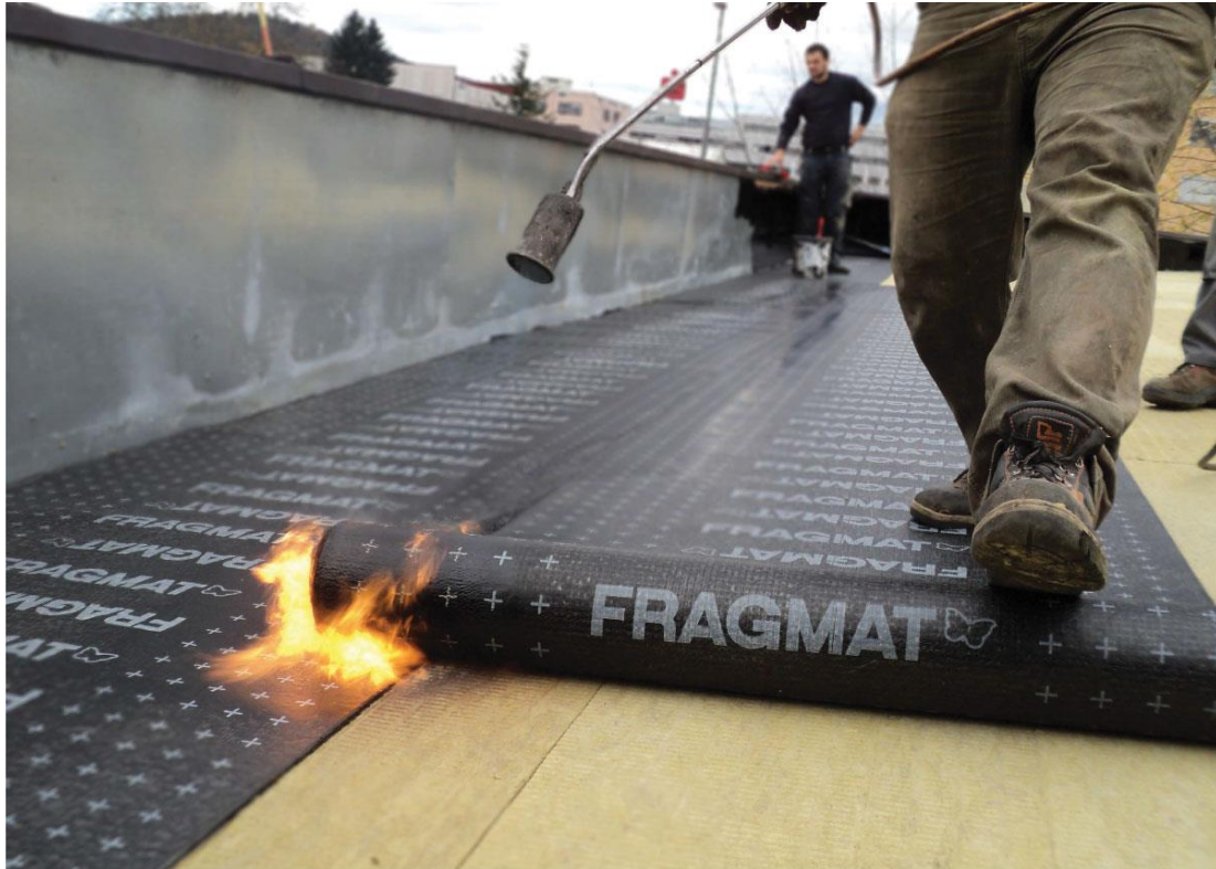
Slika 10. Spajanje preklopa toplinom
