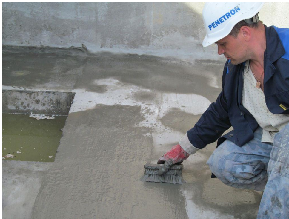
Slika 19. Nanošenje cementnog premaza četkom
