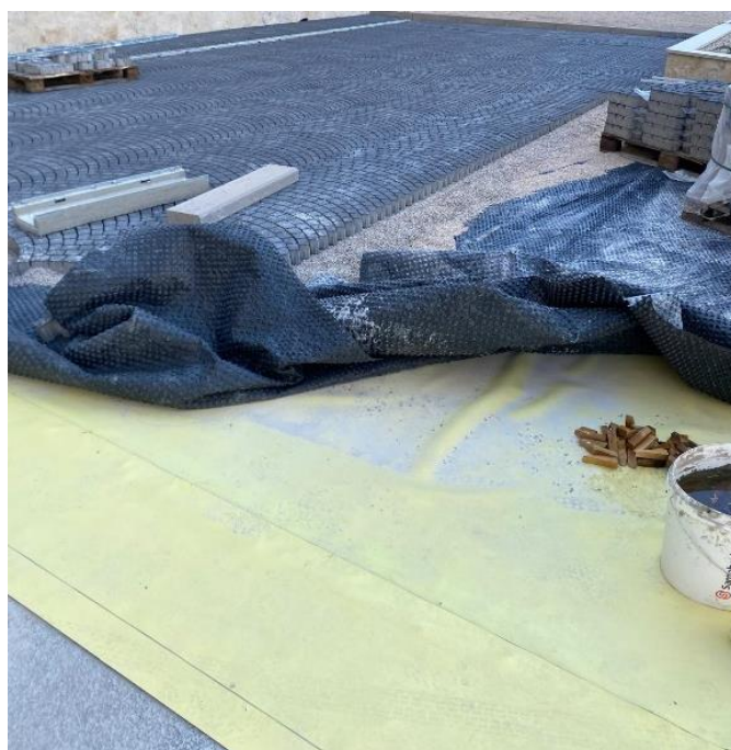
Slika 3. Sintetička membrana zaštićena geotekstilom prije zatrpavanja
