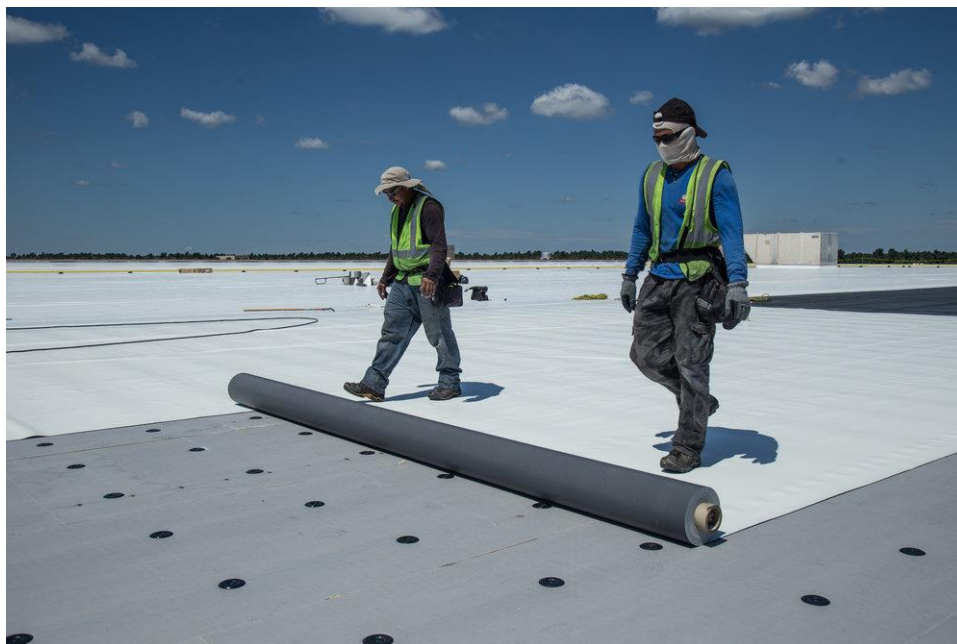
Slika 11. Postavljanje PVC membrane
