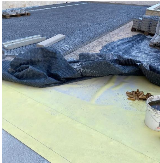
Slika 3. Sintetička membrana zaštićena geotekstilom prije zatrpavanja
