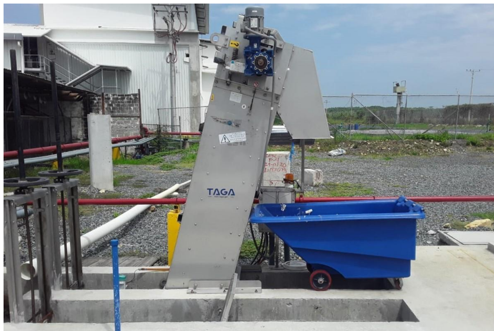
Slika 12: Mehanička rešetka s lančanim pogonom (Izvor:[10])
