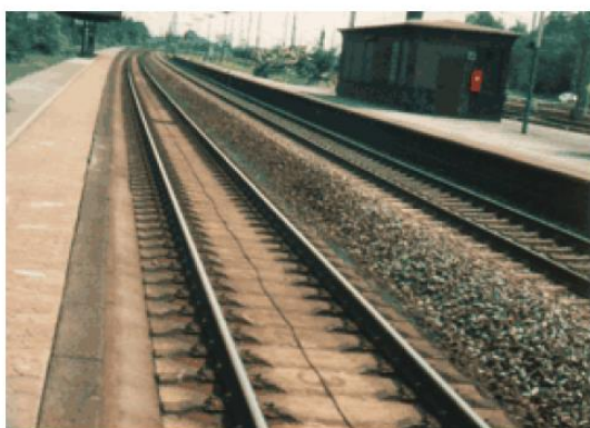
Slika 3. Kolosijek na čvrstoj podlozi sa „Rheda“ kolosiječnom konstrukcijom, a) dionica kolosijeka Rheda-Wiedenbruck željeznička stanica, b) model kolosijeka[11]
