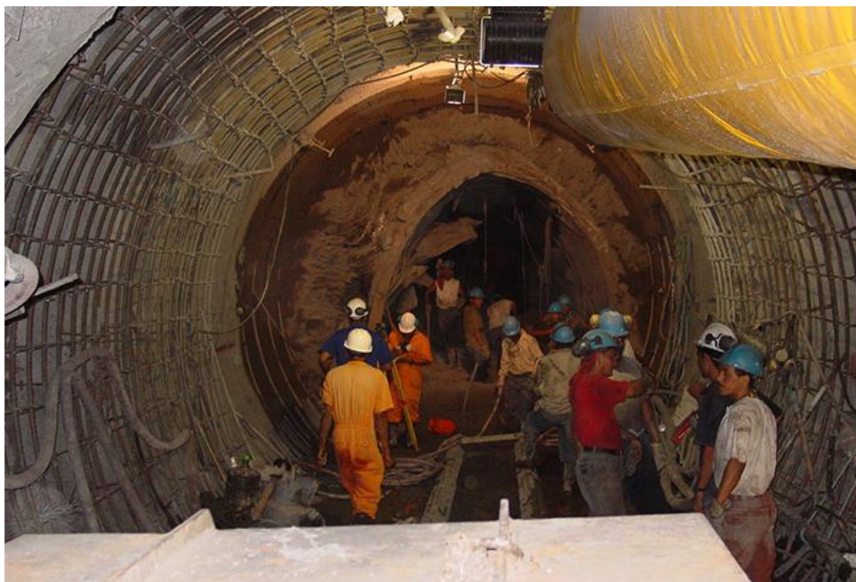
Slika 12.: Kolaps tunela Yacambú-Quibor (Izvor: [28])
