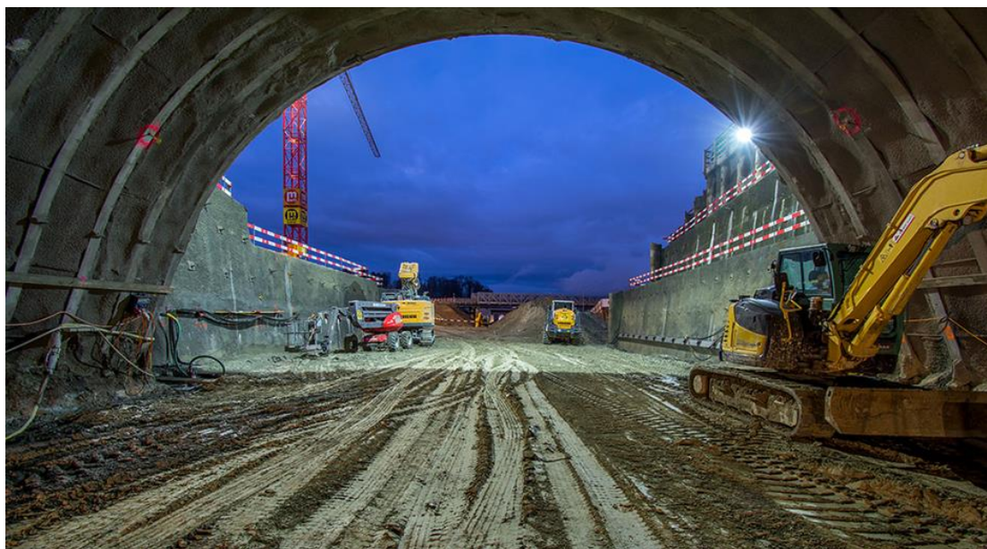
Slika 2.: Izvedena primarna podgrada (Izvor:[9])
