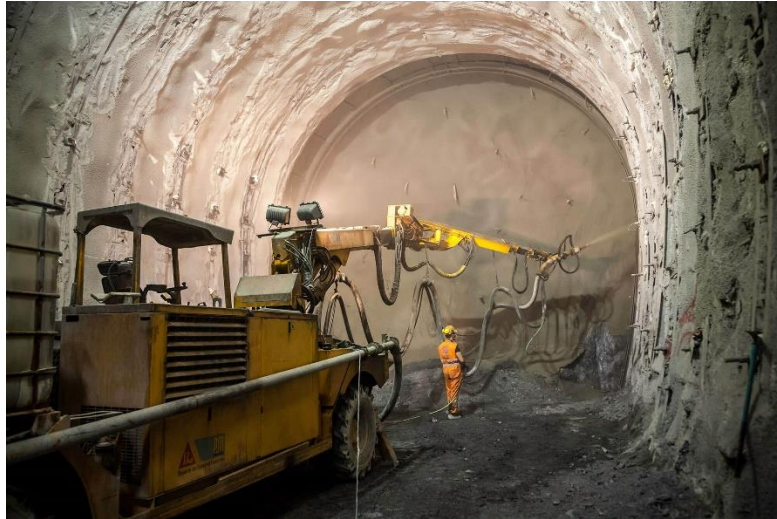
Slika 3.: Strojno nanošenje mlaznog betona (Izvor: [7])
