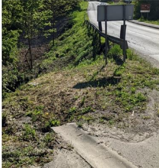
Slika 15.: Betonska kanalice na istočnoj strani ceste (Izvor: [5])
