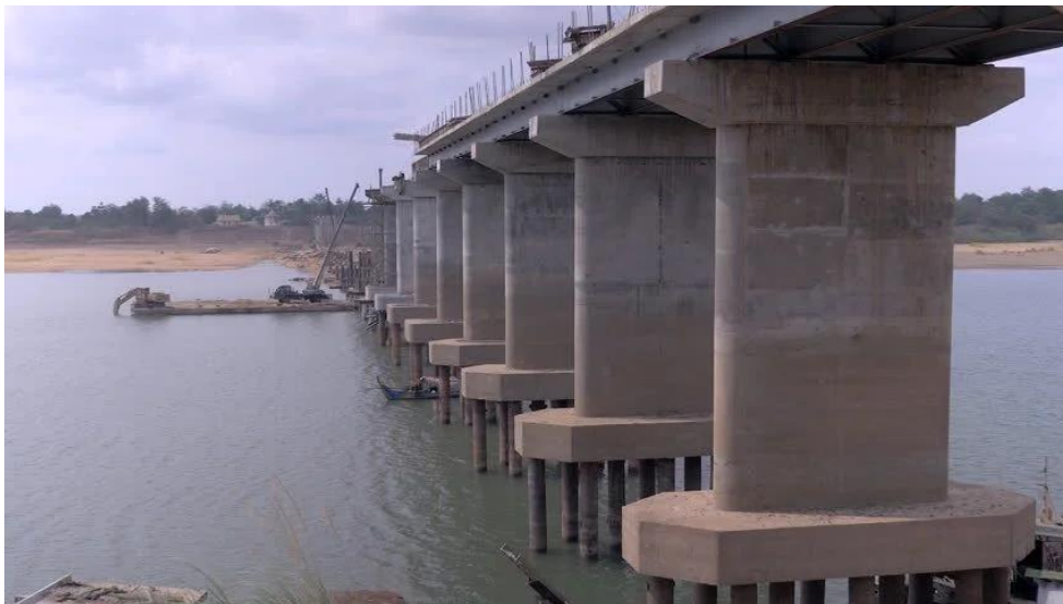
Slika 2.: Temeljenje upornjaka mosta na pilotima (Izvor: [7])
