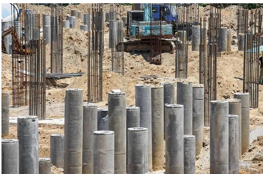
Slika 6.: Betonski piloti kružnog presjeka (Izvor: [13])
