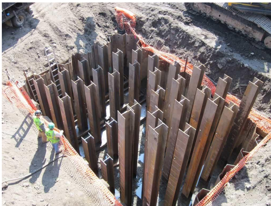
Slika 5.: Čelični piloti u obliku H-profila (Izvor: [12])
