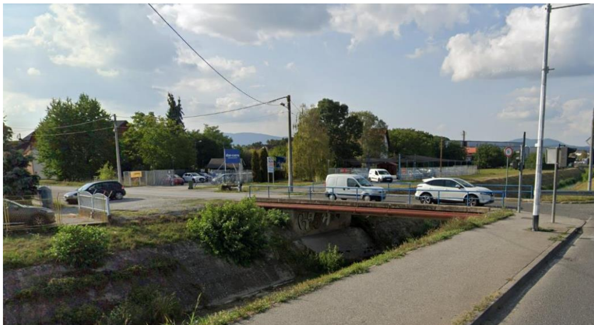
Slika 22.: Postojeći most preko potoka Vuger (Izvor: [17])
