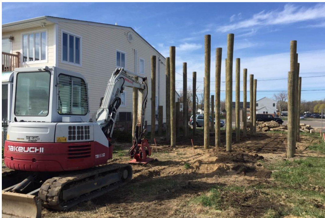
Slika 4.: Drveni piloti (Izvor: [10])
