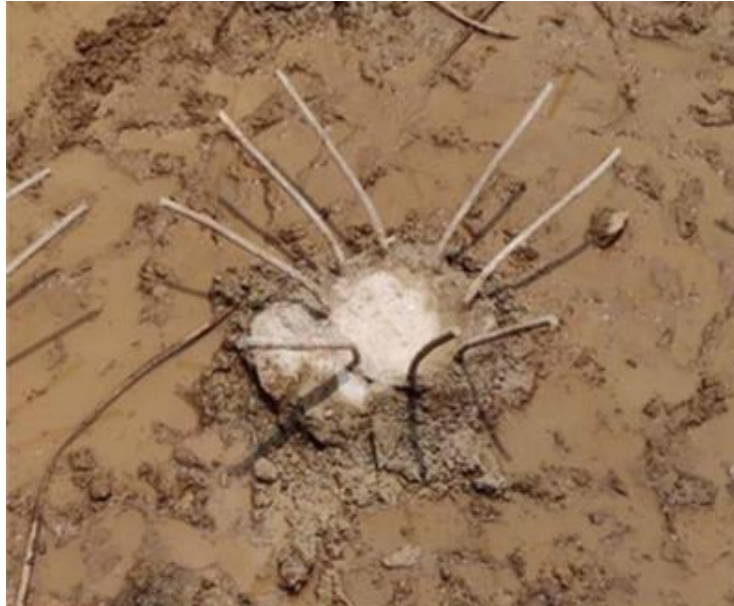
Slika 59.: Glava pilota spremna za ispitivanje cjelovitosti (Izvor: [31])
