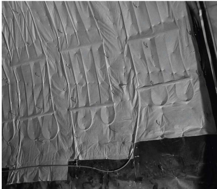
Slika 12. Prikaz energetskog geotekstila (geokompozita) instaliranog u energetskom tunelu (Izvor: [14])
