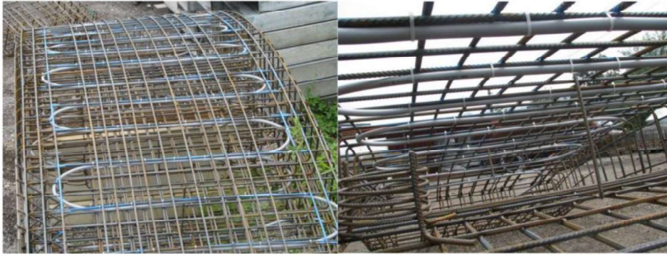
Slika 28. Prikaz postavljanja cijevi TES sustava (Izvor: [27])
