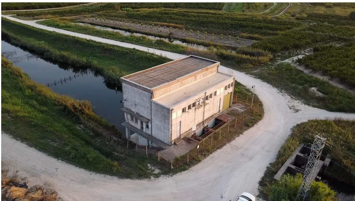
Slika 41: Crpna stanica Prag
