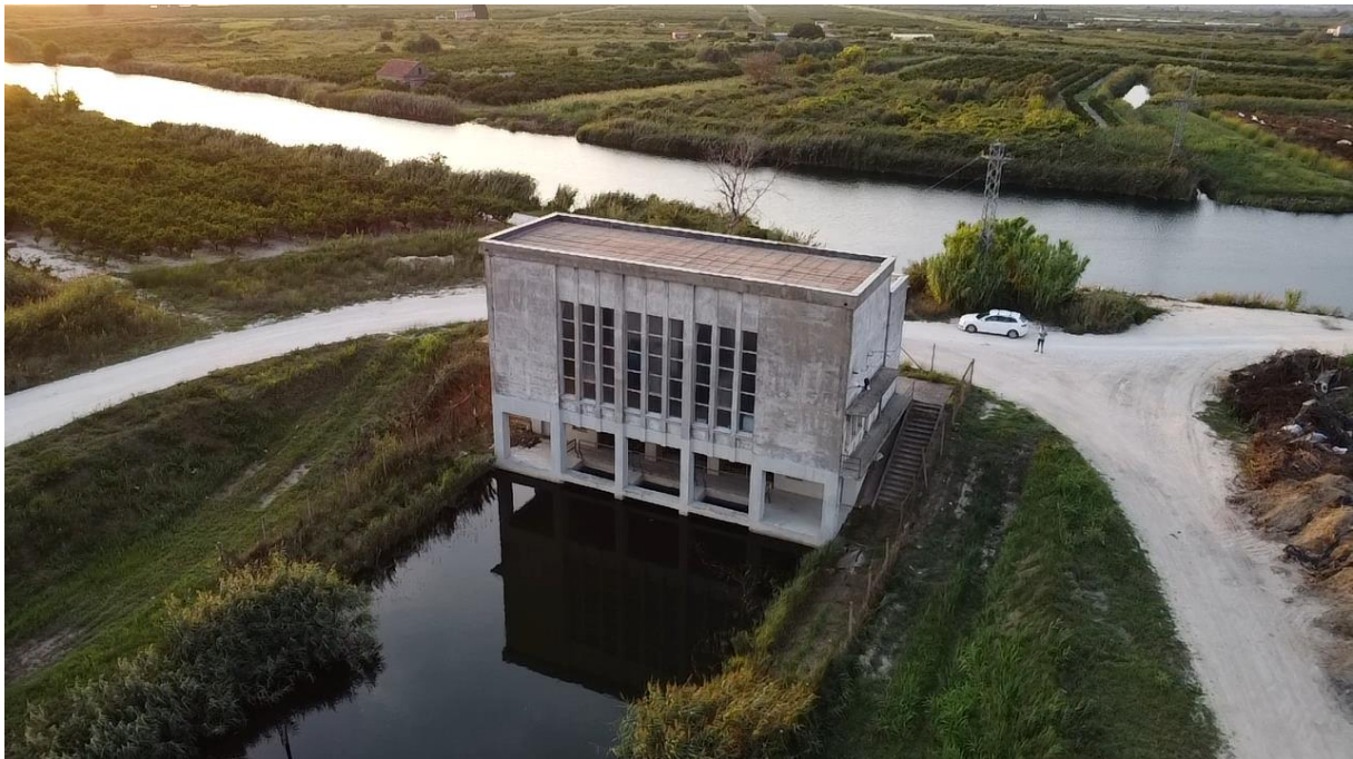
Slika 40: Crpna stanica Prag
