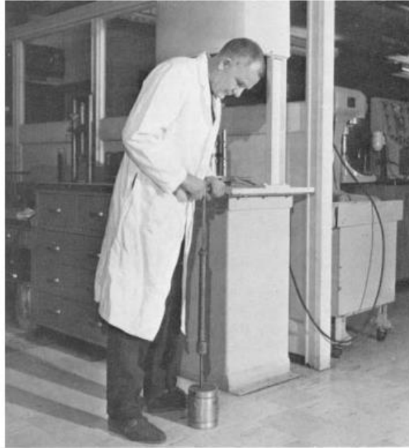
Slika 45. Položaj ispitivača i posude tijekom pokusa Proctorovom iglom [21]
