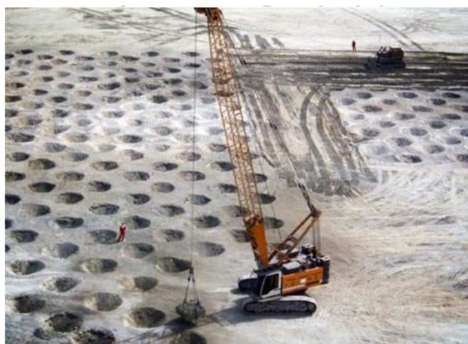
Slika 52. Primjer izvedenog dinamičkog zbijanja u prostoru [25]
