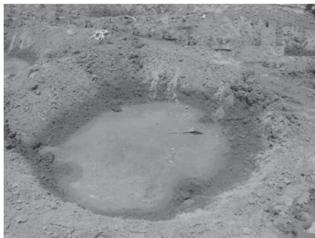
Slika 51. Krater nakon dinamičkog zbijanja [13]
