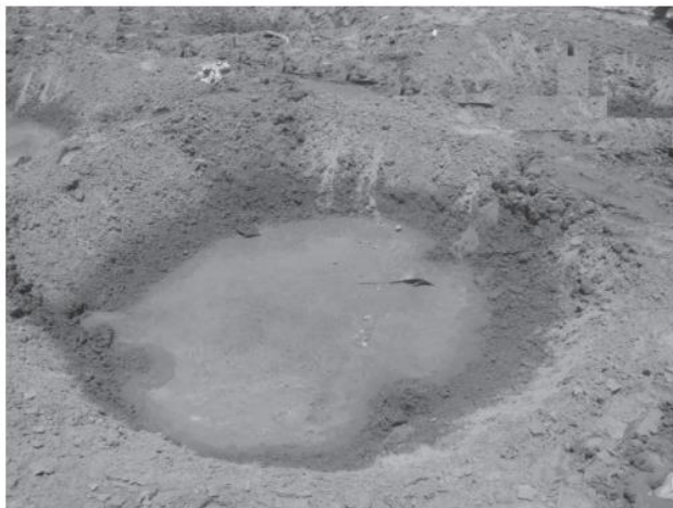
Slika 51. Krater nakon dinamičkog zbijanja [13]
