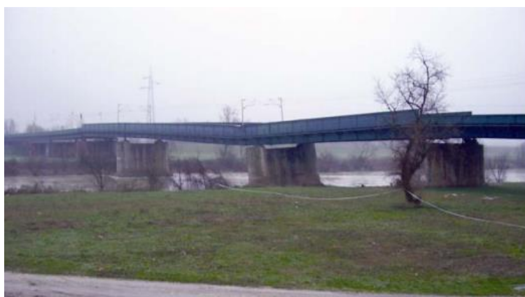
Slika 1.: Željeznički most Jakuševac (Izvor: [3])
