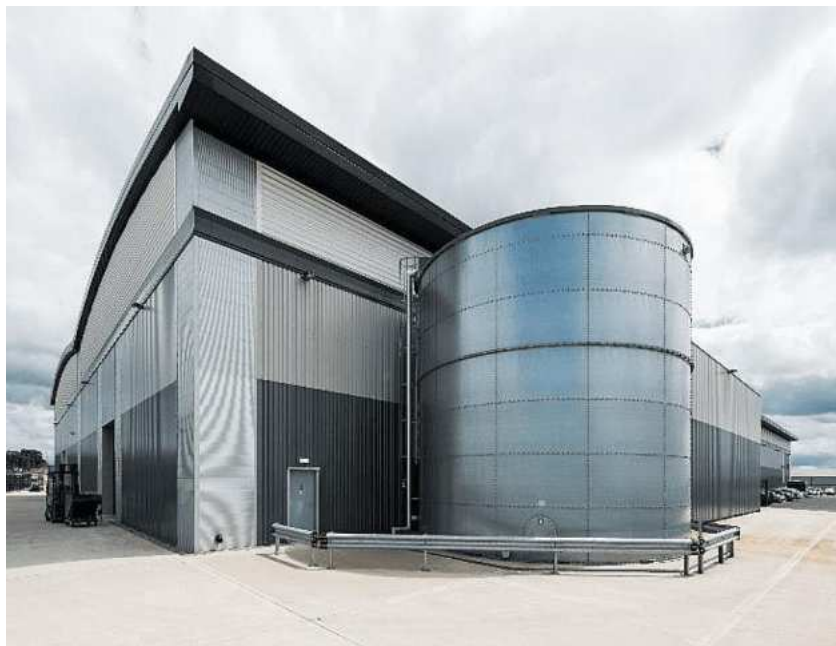
Slika 1.: Primjer tankostijene posude, sprinkler tank (Izvor: https://iit.ie/galvanised-sprinkler-tanks/ )
