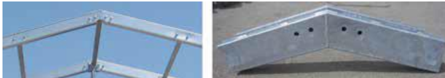
Slika 6: Priključak prečka - prečka s čeličnim umetkom [5]
