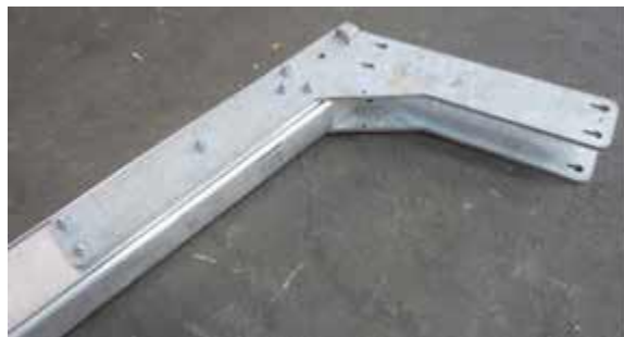
Slika 7: Priključci prečka - stup s čeličnim pločama [5]
