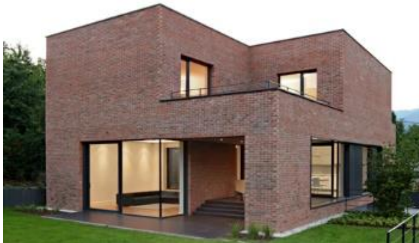
Slika 38. Kuća Podfušćak (Izvor: [42])
