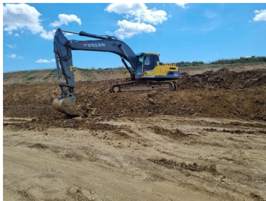
Slika 6. Strojni iskop gline (Izvor: [11])
