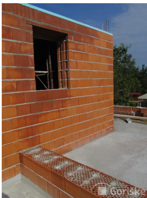
Slika 28. Otvor namjenjen prozoru (Izvor: [34])
