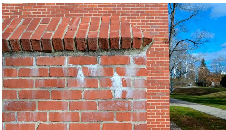
Slika 11. Iscvjetavanje na površini opeke (Izvor: [15])
