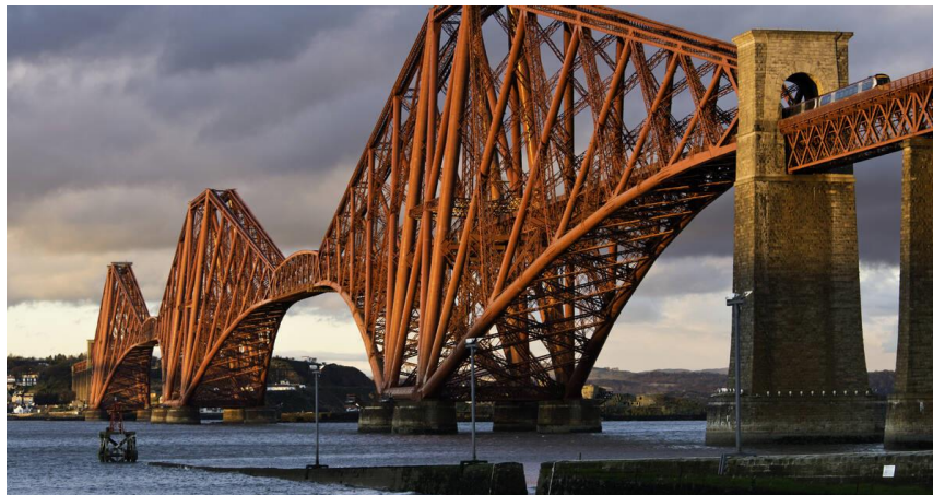
Slika 4.1. Most Forth u Škotskoj [11]
