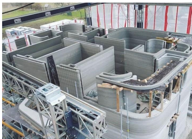
Slika 3.: 3D pisač ispisuje trokatnicu (vanjske i unutarnje zidove) [1]
