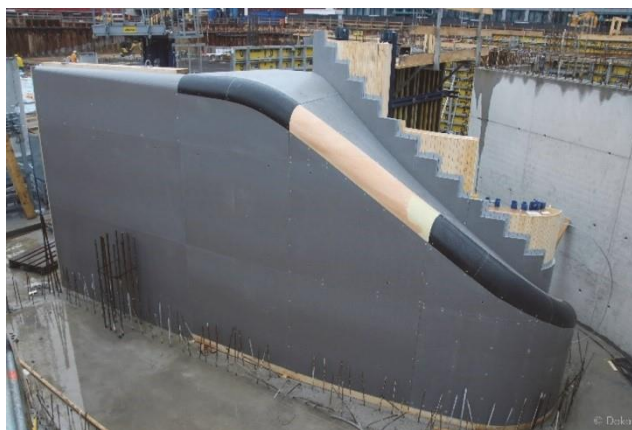
Slika 1.: 3D ispisana oplata stubišta [1]
