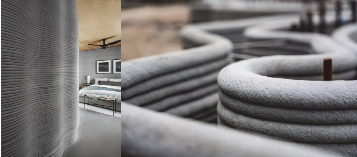
Slika 18.: Detalj zida i njegova 3D izvedba [17]
