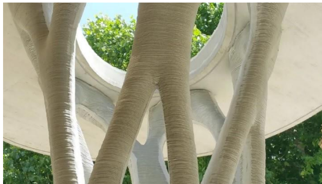
Slika 6.: Betonski stup Krypton, Aix-en-Provence, 2016., Holcim [5]
