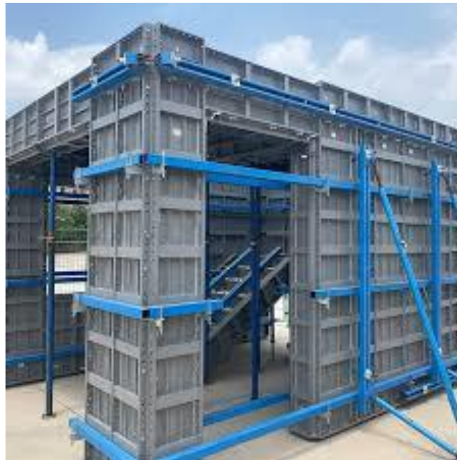
Slika 17: Aluminijska oplata zida (Izvor [19.])
