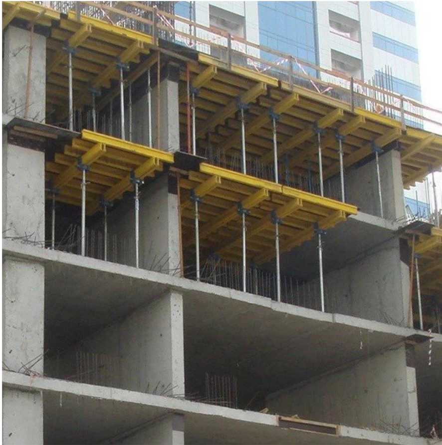
Slika 51: Oplata ploče (izvor [48.]
