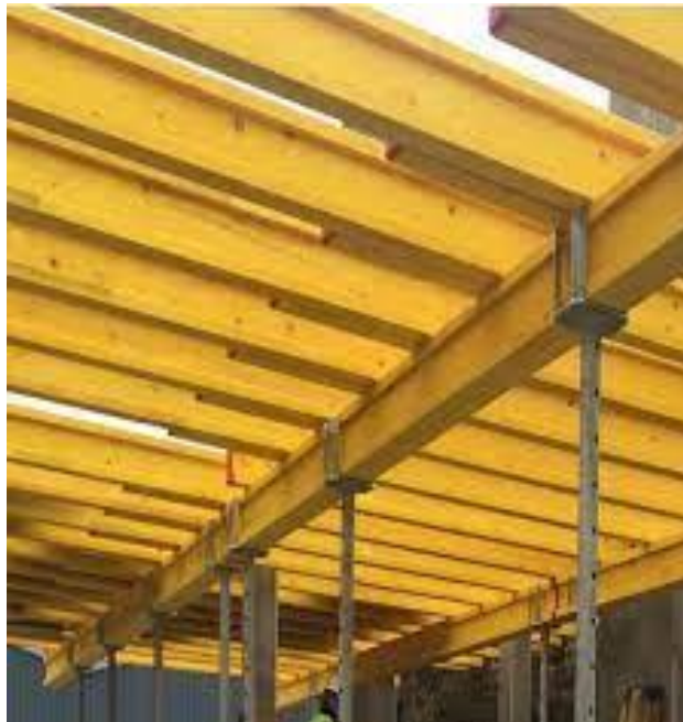
Slika 41: Potkonstrukcija od drvenih greda (Izvor [41].)
