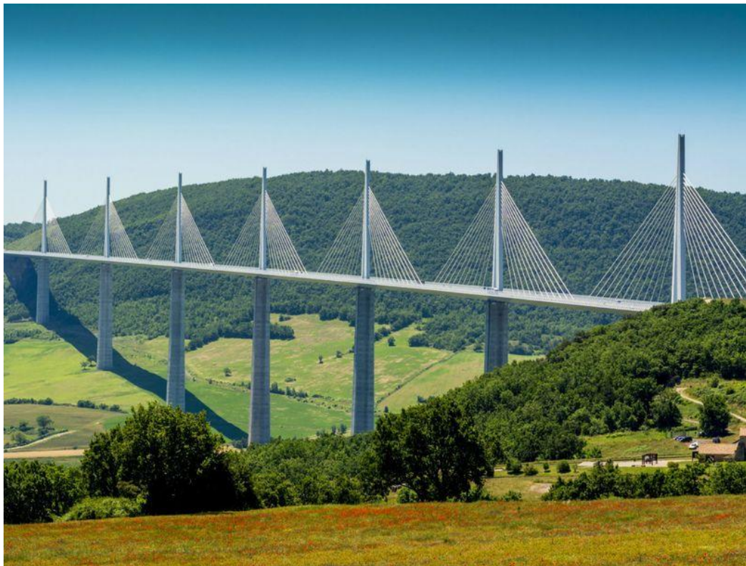
Slika 52: Millau vijadukt (Izvor [50.])
