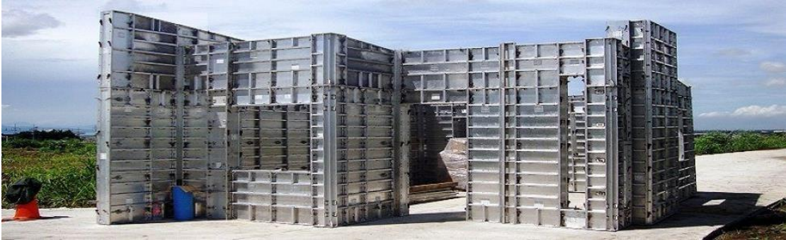
Slika 6: Aluminijska oplata (Izvor [6.])
