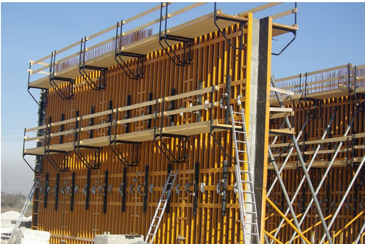
Slika 49: Primjer čeline oplata zida (Izvor [47.]
