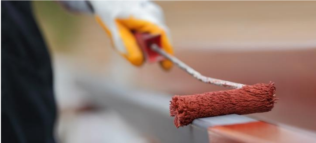
Slika 11.: Nanošenje zaštite valjkom (Izvor: [33])
