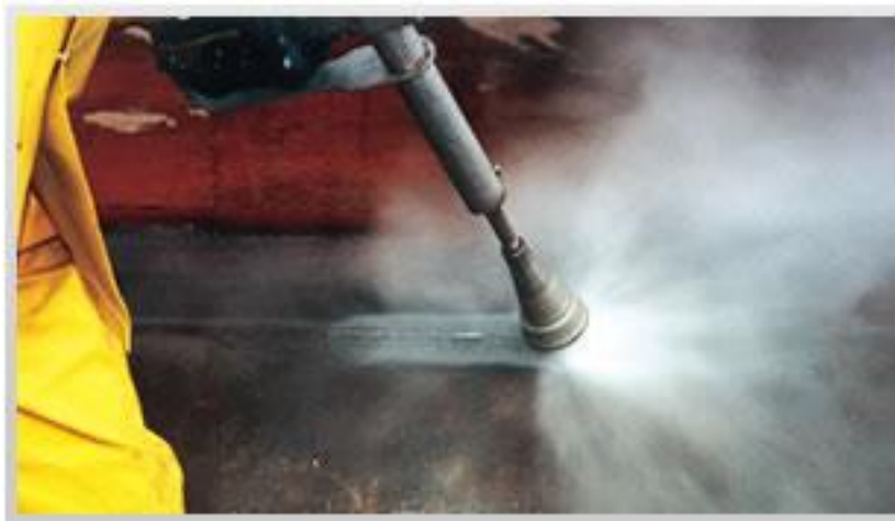
Slika 7.: Čišćenje vodenim mlazom ultra visokog pritiska (Izvor: [29])
