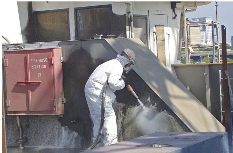
Slika 6.: Čišćenje mokrim pjeskarenjem (Izvor: [5])
