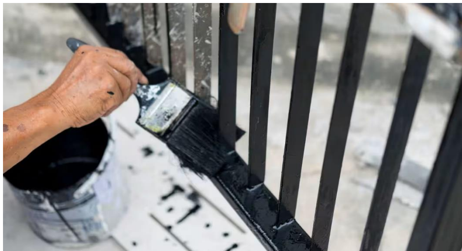
Slika 10.: Nanošenje zaštite boje kistom (Izvor: [32])
