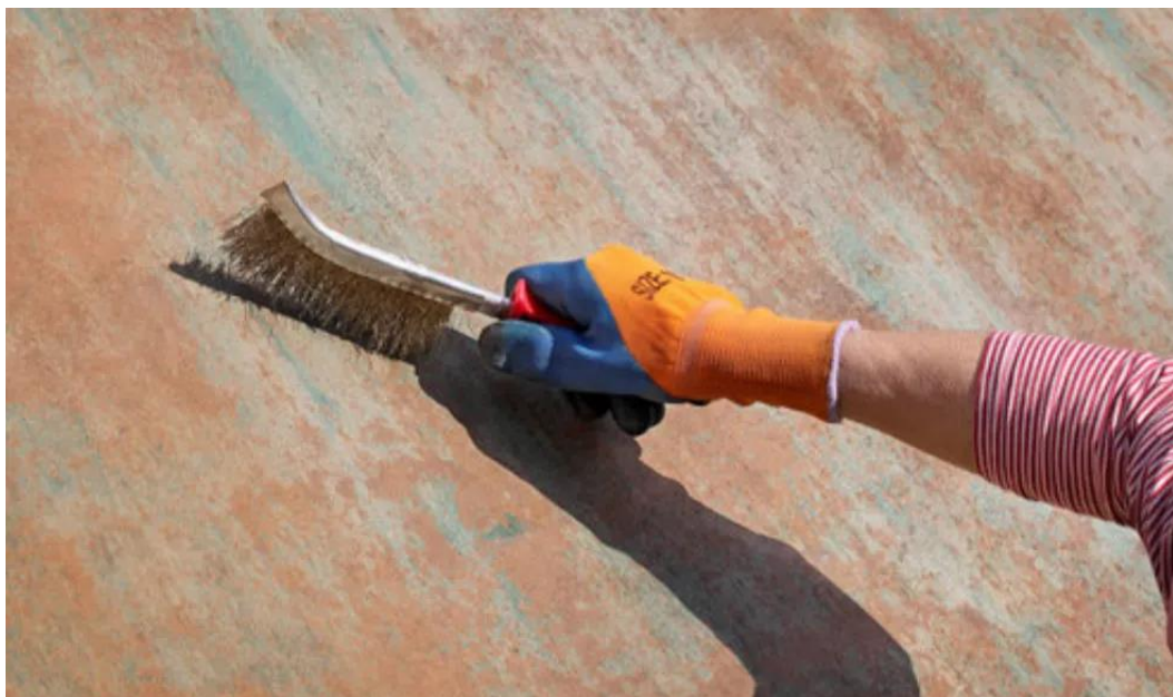
Slika 4.: Primjer čišćenja ručnom četkom (Izvor: [30])
