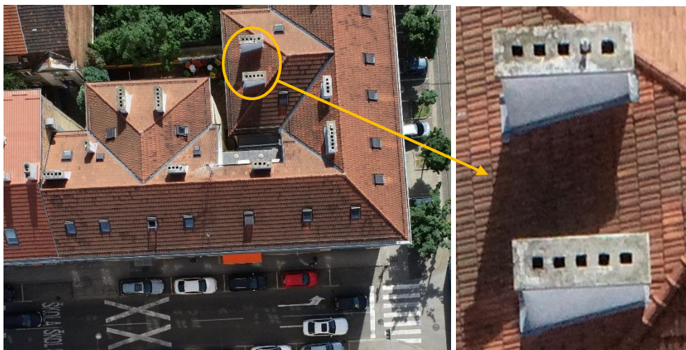
Slika 16. Mjesta uobičajenih oštećenja (RGB kamera na dronu)
