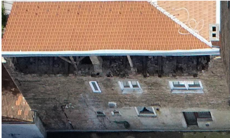
Slika 12. Urušeni zabatni zid (RGB kamera na dronu)
