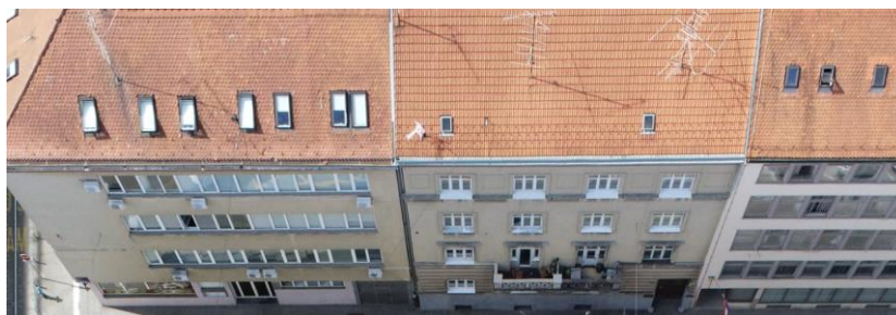
Slika 53. Veliki otvori upućuju na primjenu armiranog betona (RGB kamera)
