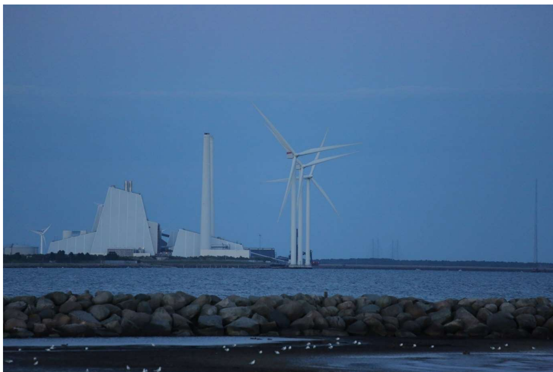
Slika 24 Prototip vjetroturbine Siemens SWT-3.6-120, Hvidovre, vjetropark Avedøre Holme, Danska (Izvor: [39])
