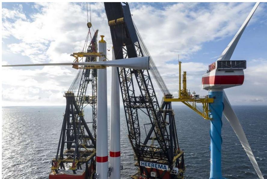
Slika 14 Instalacija lopatica na vjetroturbinu (Izvor: [27])
