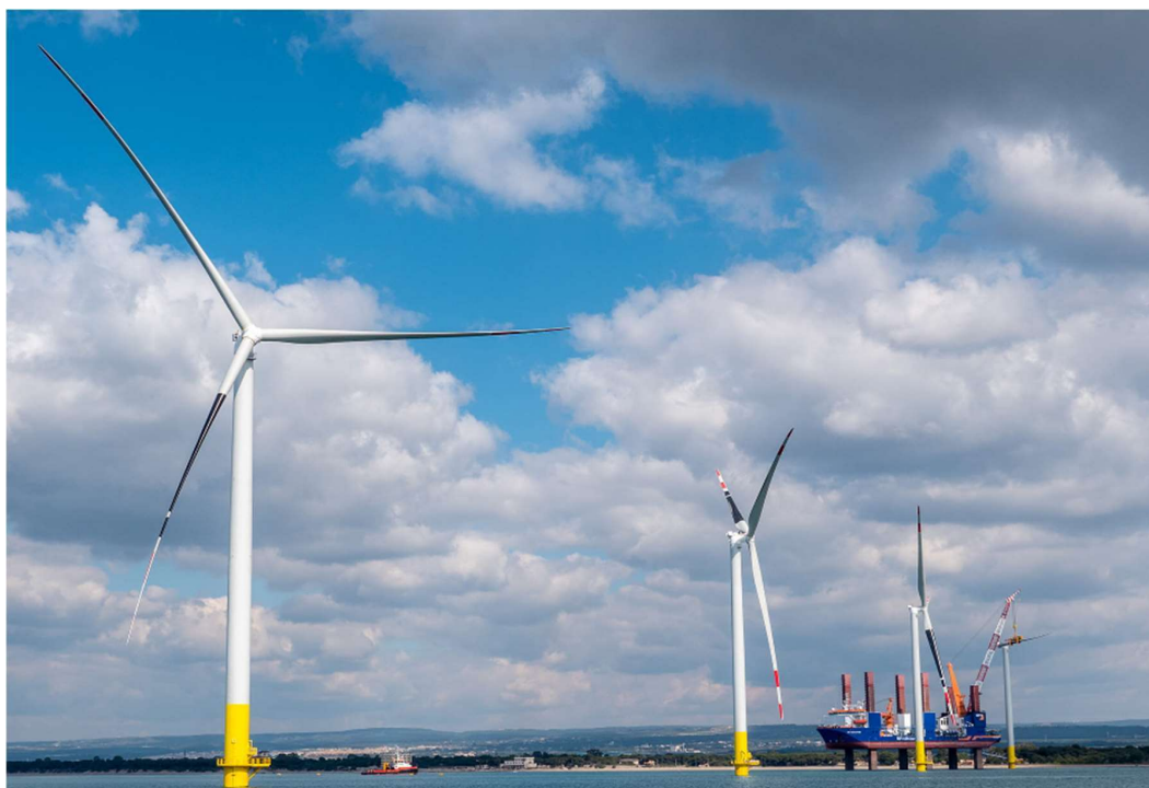
Slika 16 Izvedba vjetroturbina u Luci Taranto (Izvor: [32])
