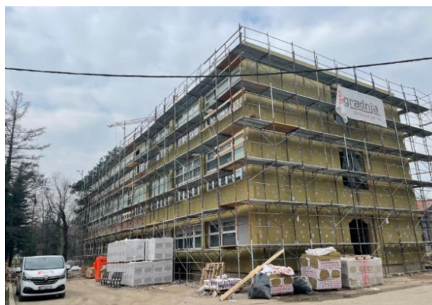
Slika 86.: Radovi obnove pri završetku [26]
