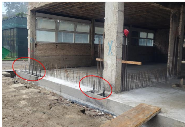
Slika 85.: Izvedena su geotehnička sidra [26]
