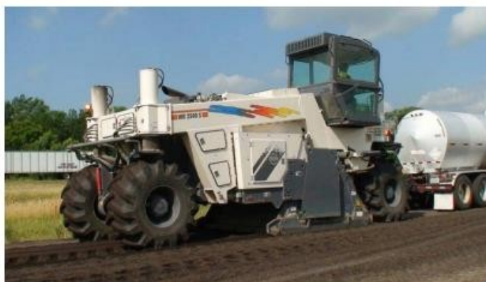
Slika 4.19. Strojna ugradnja letećeg pepela u cilju stabilizacije tla (Kuelh i dr., 2017.)
