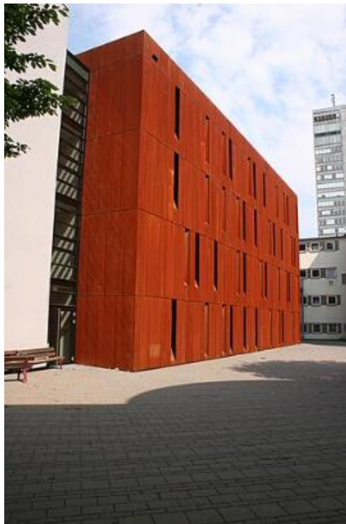
Slika 13.: Primjer građevine od Corten čelika [22]
