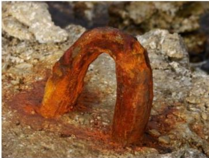
Slika 3.: Primjer kemijske korozije [7]
