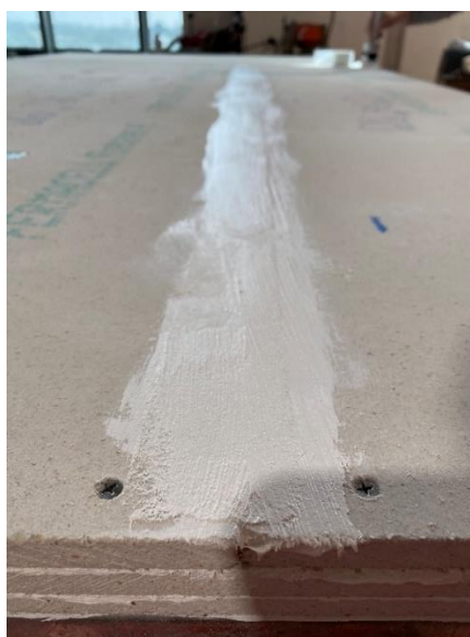
Slika 10: Intumescentni materijal za spojeve ploča
