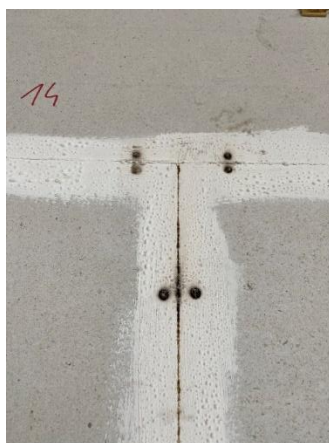
Slika 21: Detalj spoja ploča Panela 1
