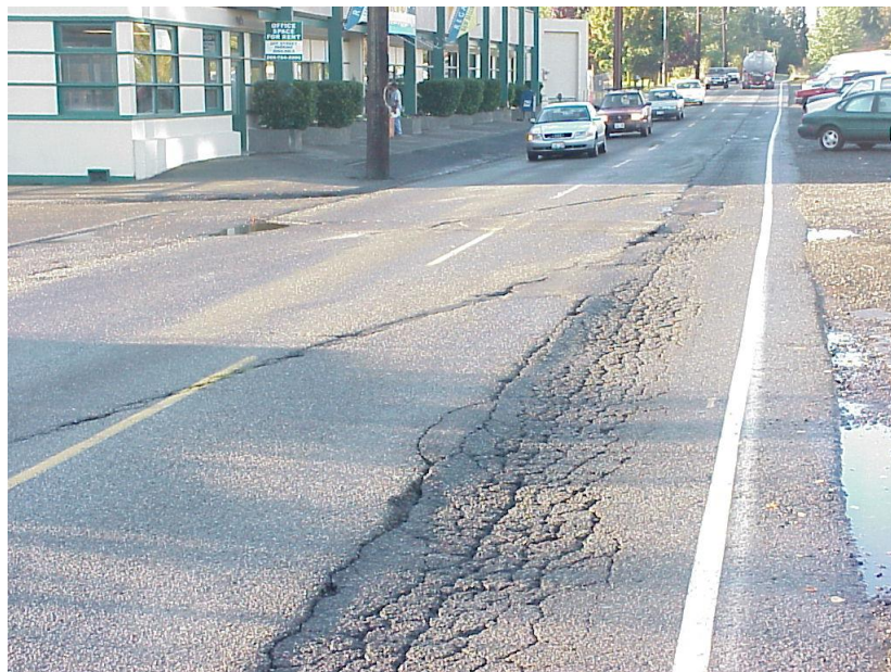
Slika 10: Kolotrazi na asfaltnom kolniku [18]
