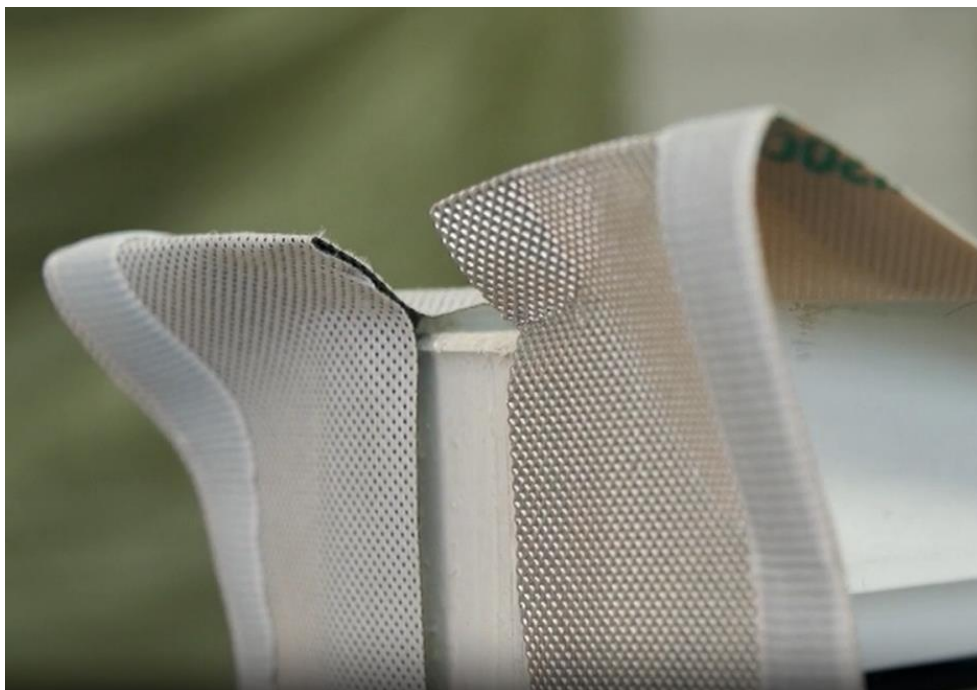
Slika 23. Način lijepljenja trake na rubovima [24]
