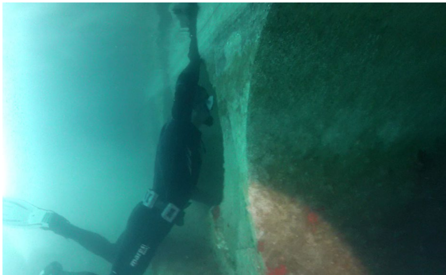
Slika 21 Propusti kružnog poprečnog presjeka ugrađeni u lukobran u ACI marini Opatija (autor fotografije: Dalibor Carević)
