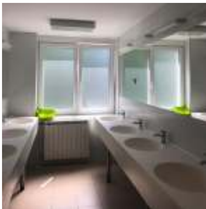
Slika 20 Stanje nakon obnove – umivaonica
