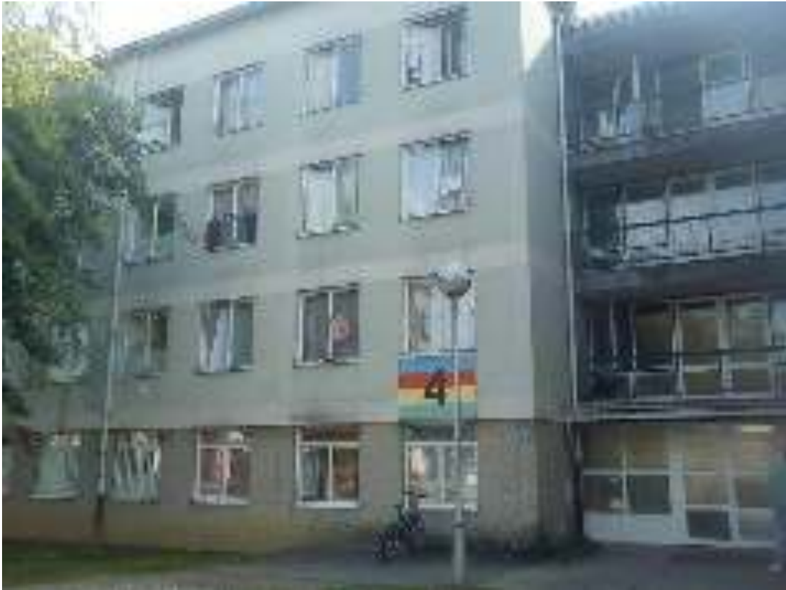
Slika 9 Stanje prije obnove – vanjski izgled paviljona (Srednja.hr, 2013)
