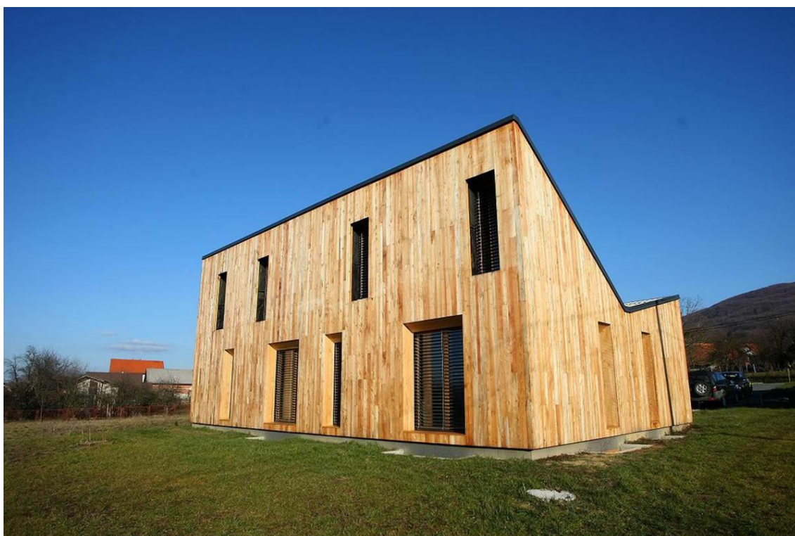
Slika 3.2. Kuća od slame, Zaprešić
