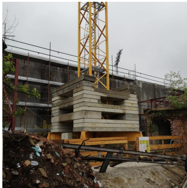
Slika 35 Ograda oko postolja toranjske dizalice
