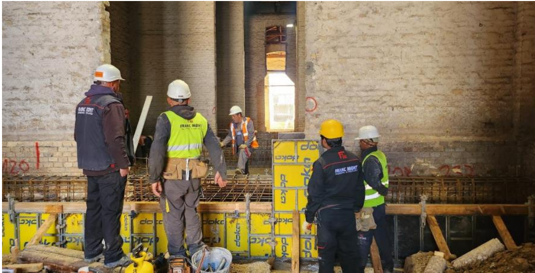
Slika 36 Korištenje osobnih zaštitnih sredstava za rad
