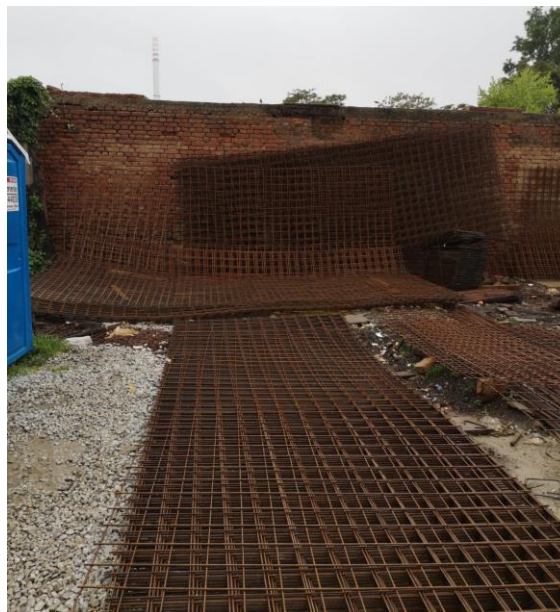
Slika 40 Neuredno skladište armature
