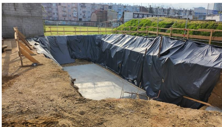
Slika 18 Iskop za sprinkler bazen
