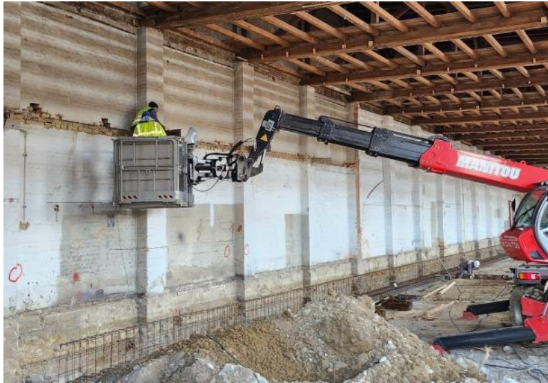
Slika 17 Uklanjanje ostataka čeličnih nosača
