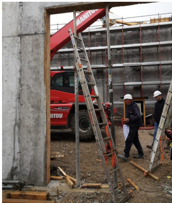
Slika 38 Nepravilno korištenje ljestvi
