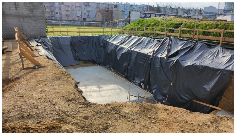
Slika 18 Iskop za sprinkler bazen
