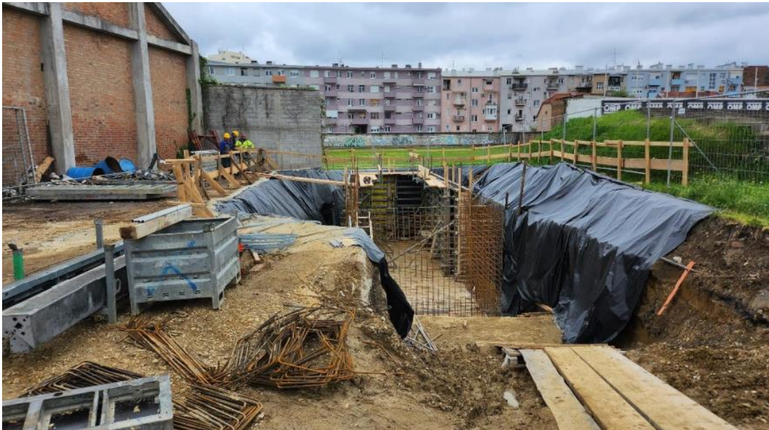
Slika 25 Postavljanje ograde oko iskopa sprinkler bazena
