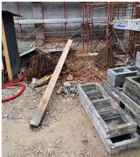
Slika 37 Neuredno gradilište
