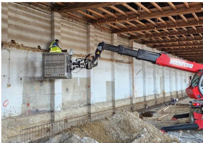
Slika 17 Uklanjanje ostataka čeličnih nosača
