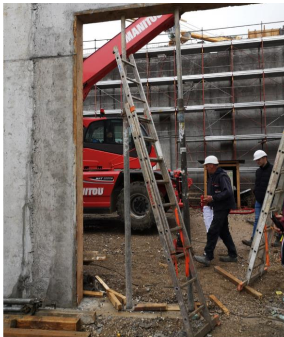
Slika 38 Nepravilno korištenje ljestvi
