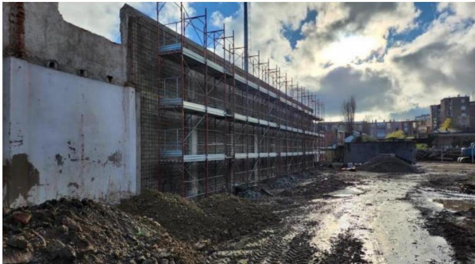
Slika 31 Postavljanje armature za torkretiranje pomoću cijevne skele
