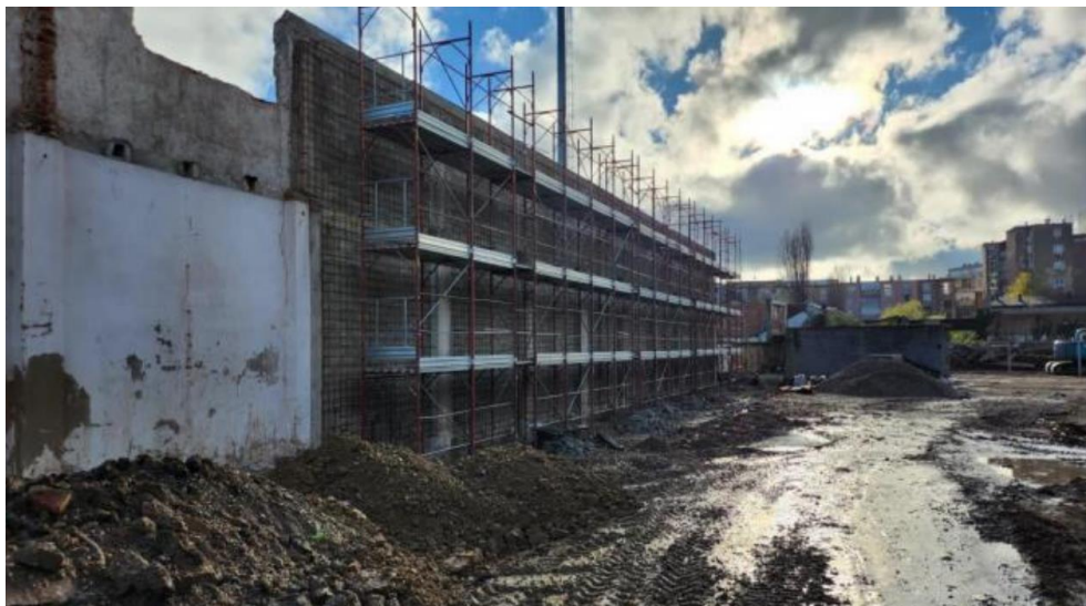
Slika 31 Postavljanje armature za torkretiranje pomoću cijevne skele
