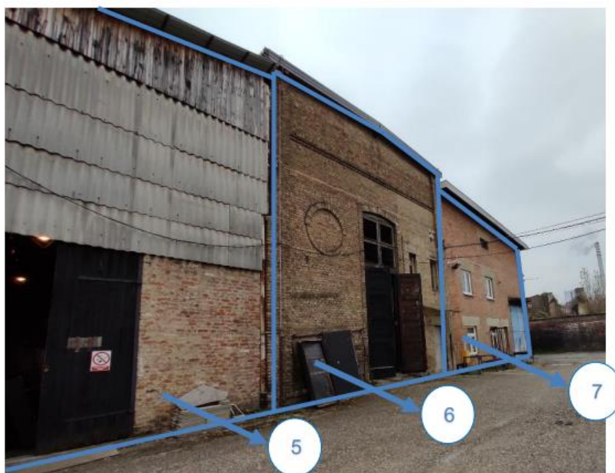
Slika 6 Zgrade 5 – lijevo, 6 – sredina i 7 – desno (Jeren, 2022).
