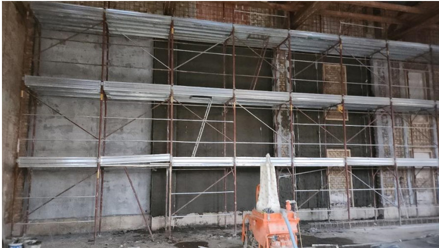
Slika 30 Cijevna skela za izvođenje torkreta
