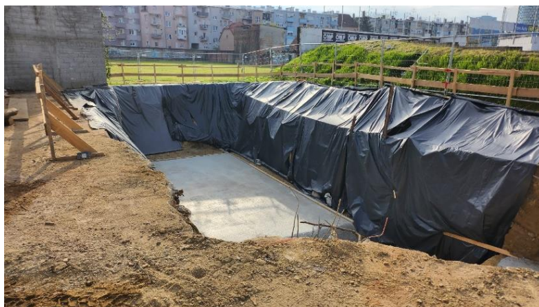
Slika 18 Iskop za sprinkler bazen
