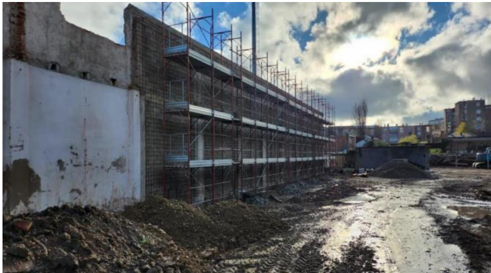
Slika 31 Postavljanje armature za torkretiranje pomoću cijevne skele
