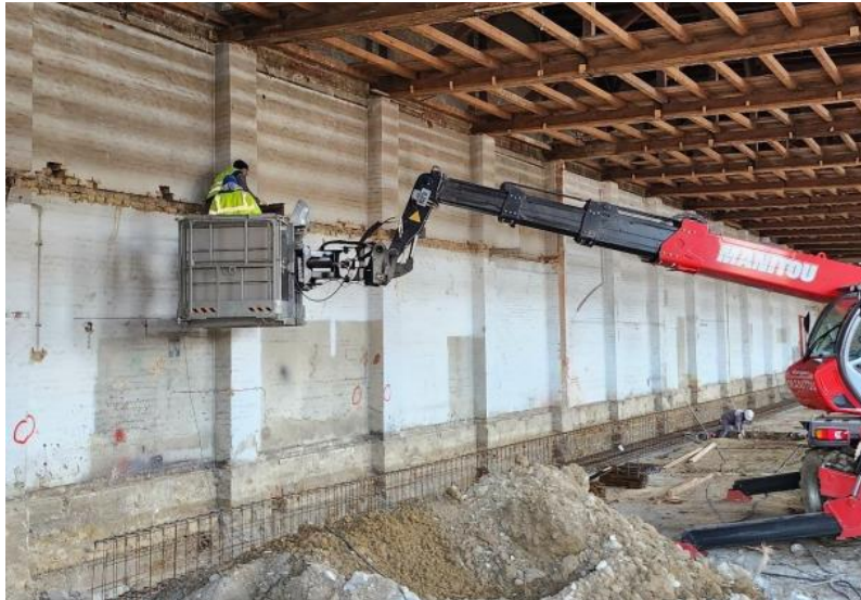
Slika 17 Uklanjanje ostataka čeličnih nosača
