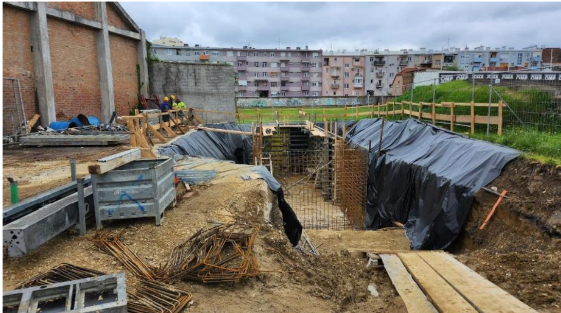
Slika 25 Postavljanje ograde oko iskopa sprinkler bazena
