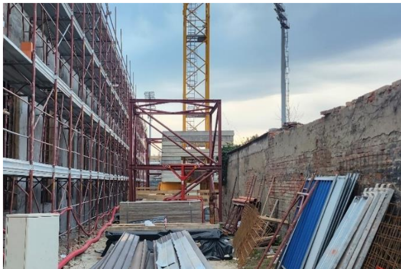
Slika 16 Montažna čelična konstrukcija
