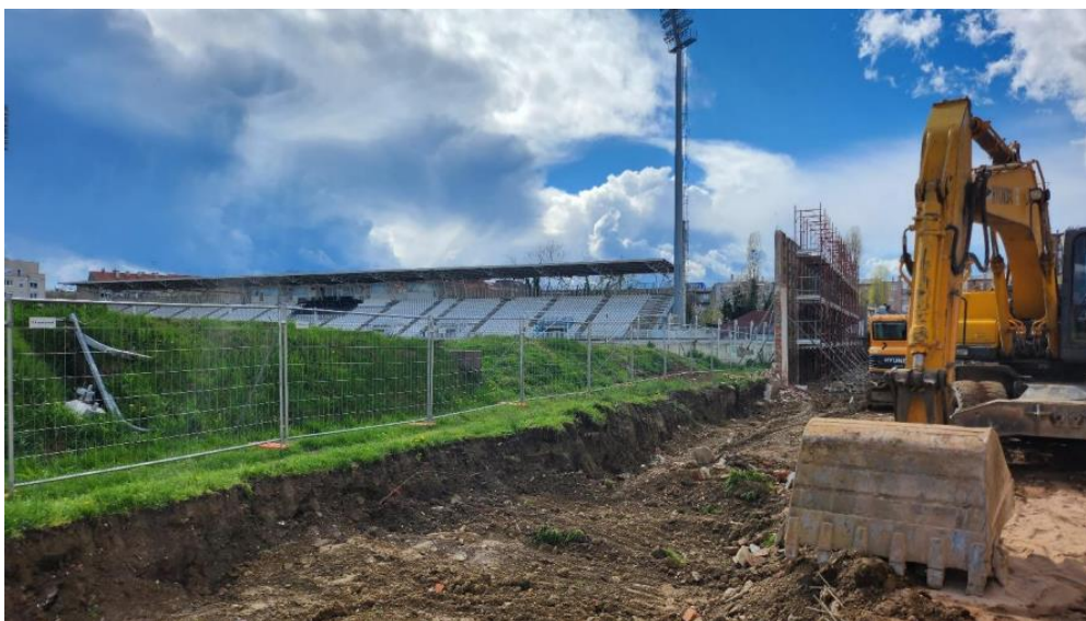
Slika 33 Čelična ograda s južne strane gradilišta
