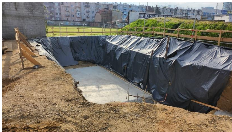
Slika 18 Iskop za sprinkler bazen
