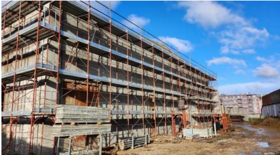
Slika 19 Propisno izvedena skela na gradilištu
