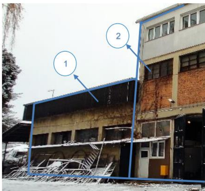
Slika 3 Zgrade 1 – lijevo i 2 – desno (Jeren, 2022).
