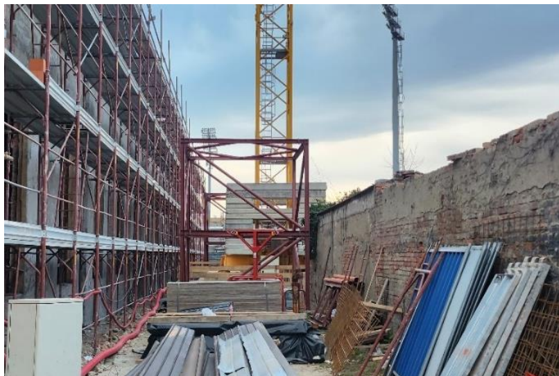
Slika 16 Montažna čelična konstrukcija
