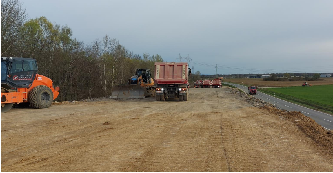
Slika 28. Strojna grupa pri izradi nasipa (vlastita fotografija, 2023)
