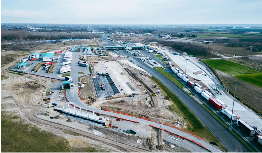
Slika 18. Aktivno gradilište na Horgošu (GP Jadran d.o.o., 2022)
