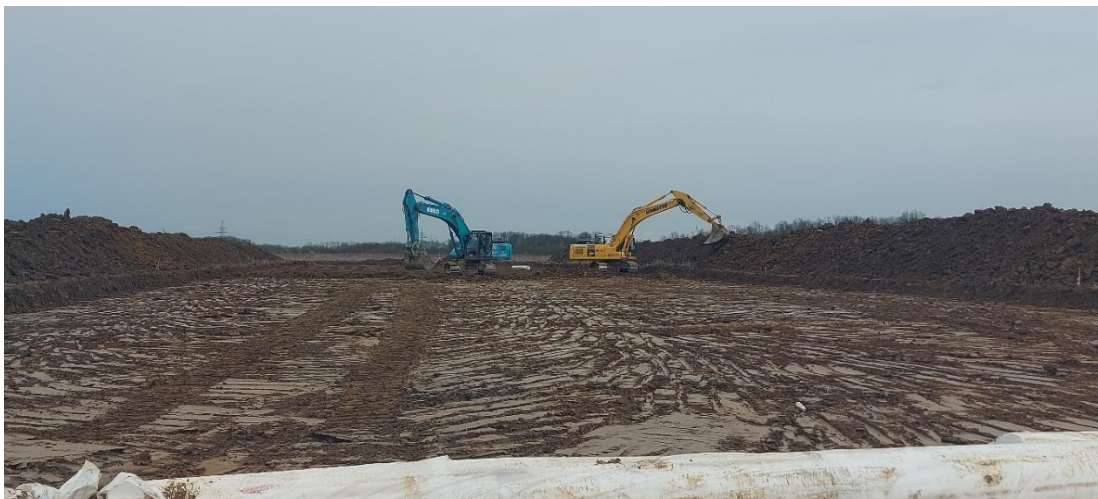
Slika 25. Strojni rad bagera na iskopu humusa (vlastita fotografija, 2023)
