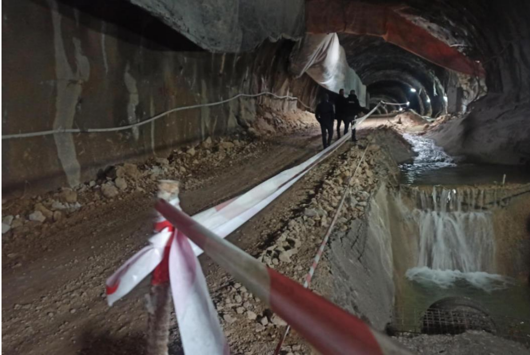
Slika 9. Evakuacija vode iz tunela Hranjen (Torche, 2019)
