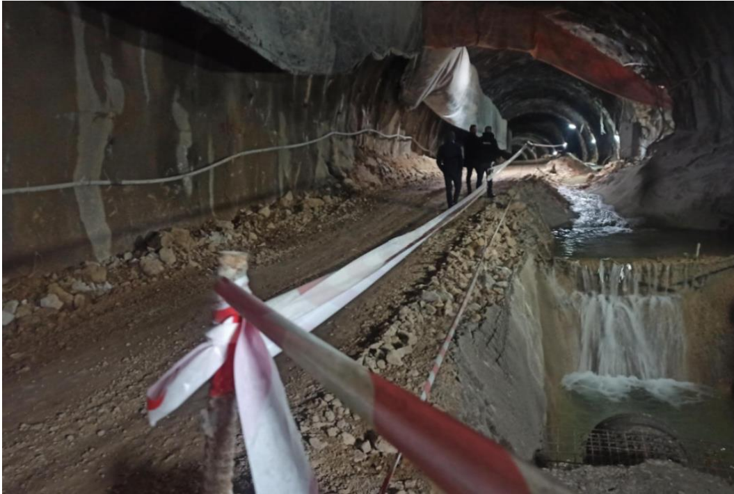
Slika 9. Evakuacija vode iz tunela Hranjen (Torche, 2019)
