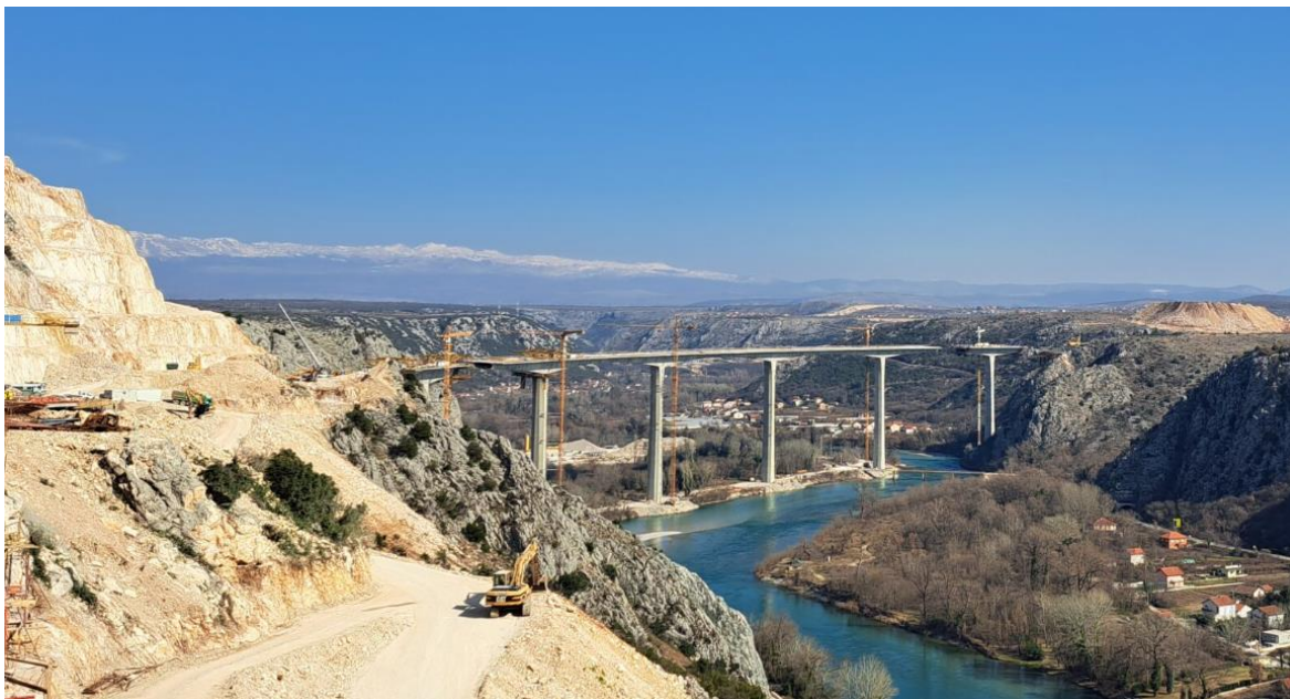
Slika 13. Gradilište mosta Počitelj (JP Autoceste FBiH d.o.o., 2022)
