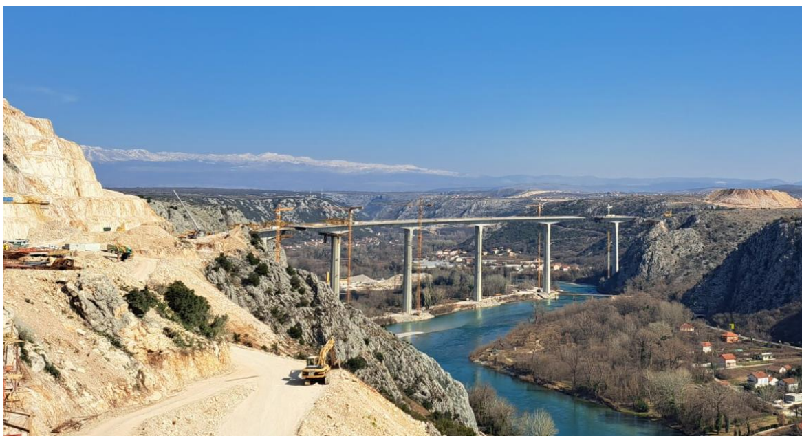
Slika 13. Gradilište mosta Počitelj (JP Autoceste FBiH d.o.o., 2022)
