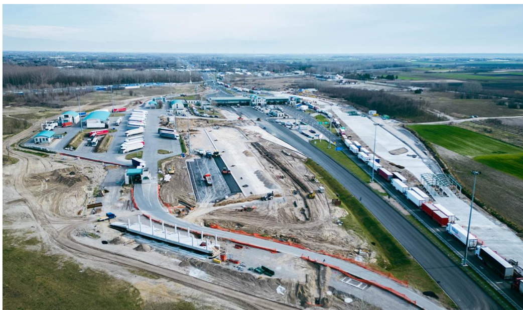
Slika 18. Aktivno gradilište na Horgošu (GP Jadran d.o.o., 2022)
