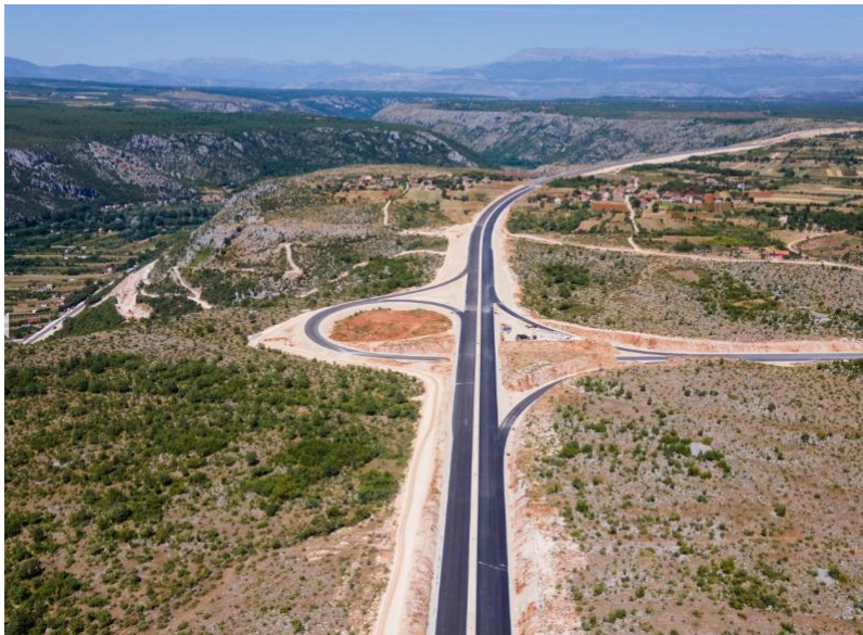
Slika 15. Gradilište u blizini Počitelja, poddionica Počitelj - Zvirovići (JP Autoceste FBiH, 2022)
