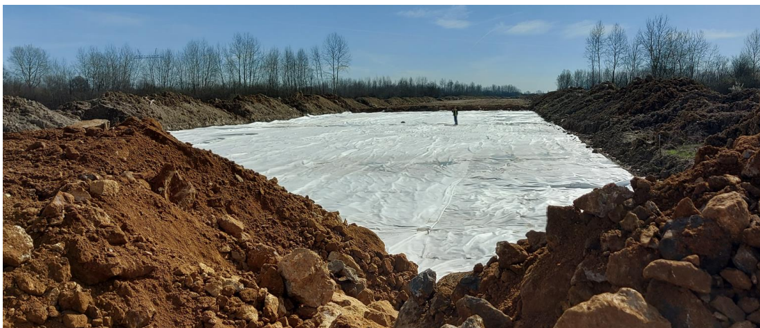
Slika 26. Kontrola radova na postavljanju geotekstila (vlastita fotografija, 2023)
