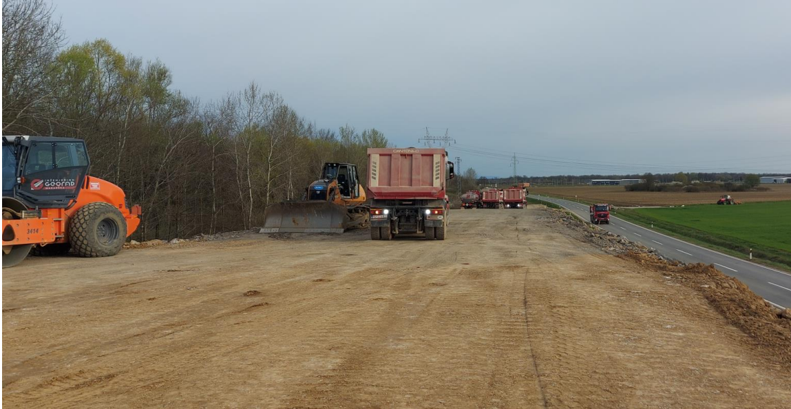
Slika 28. Strojna grupa pri izradi nasipa (vlastita fotografija, 2023)
