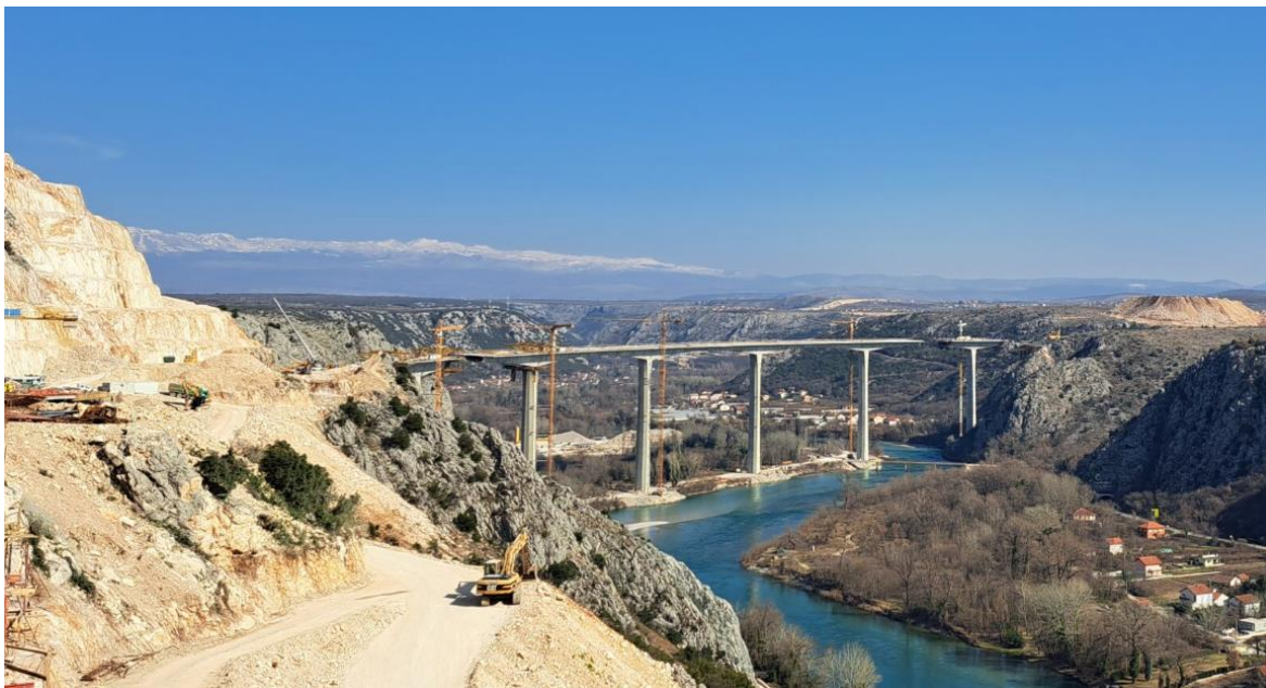
Slika 13. Gradilište mosta Počitelj (JP Autoceste FBiH d.o.o., 2022)
