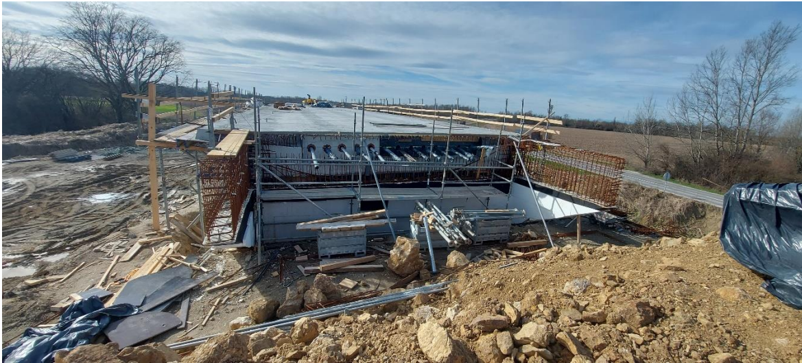
Slika 24. Nadvožnjak Sela prije izvedbe klina (vlastita fotografija, 2023)
