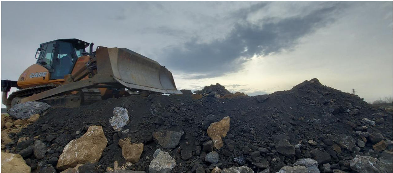
Slika 27. Ugradnja troske u slojeve nasipa (vlastita fotografija, 2023)
