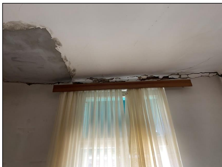
Slika 20 Drobljenje stropa trećeg kata lijevoga stana
