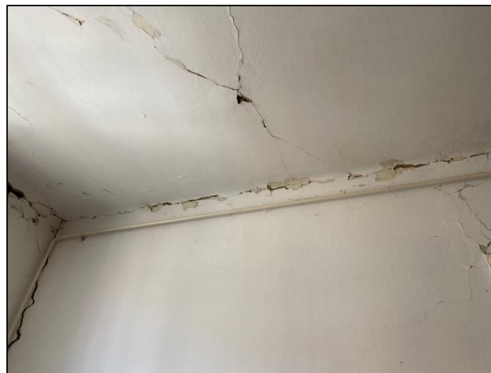
Slika 16 Horizontalna oštećenja na razini stropa trećeg kata lijevog stana
