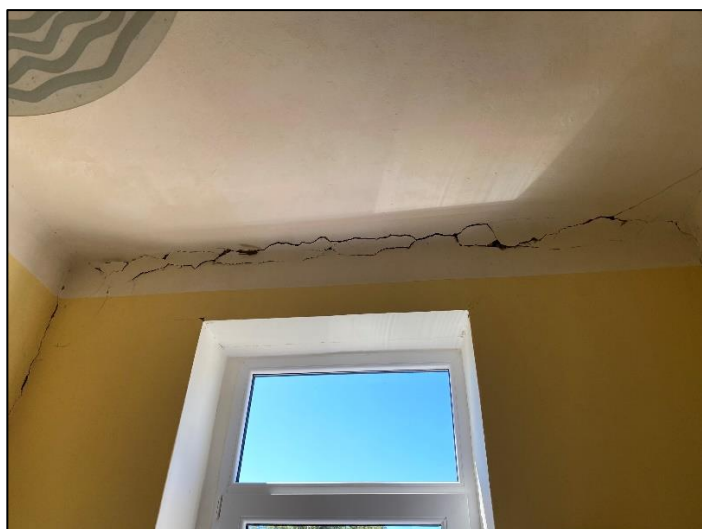
Slika 16 Horizontalna oštećenja na razini stropa trećeg kata lijevog stana
