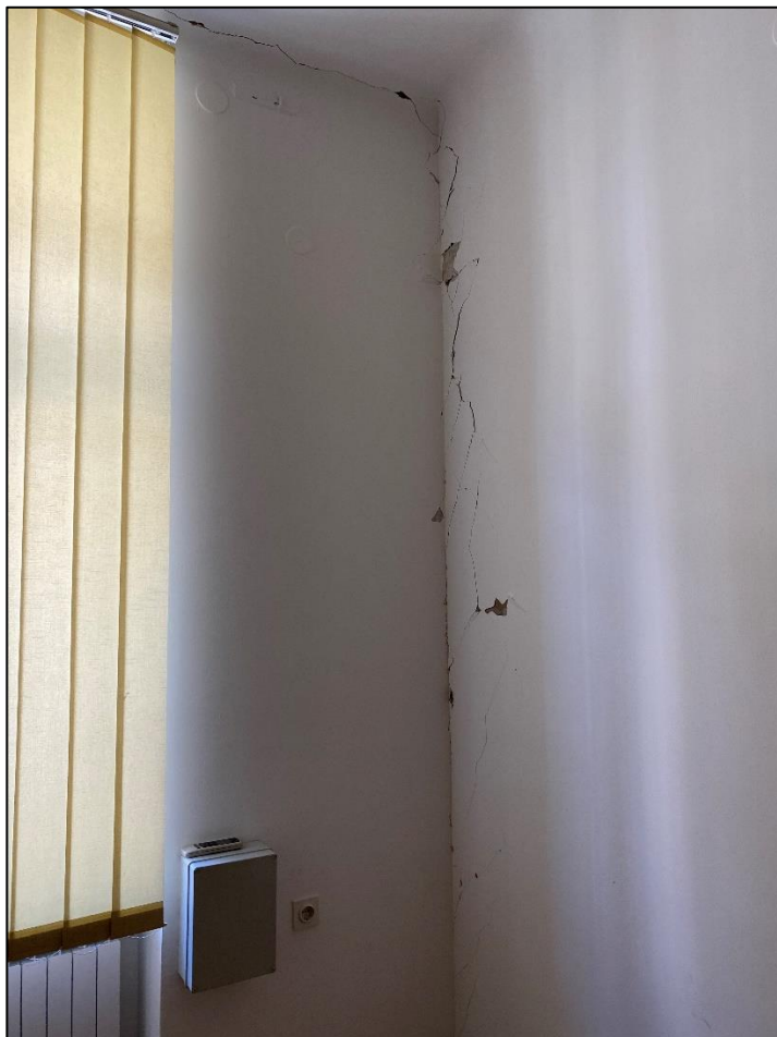
Slika 14 Vertikalna oštećenja na spojevima okomitih zidova drugoga kata
