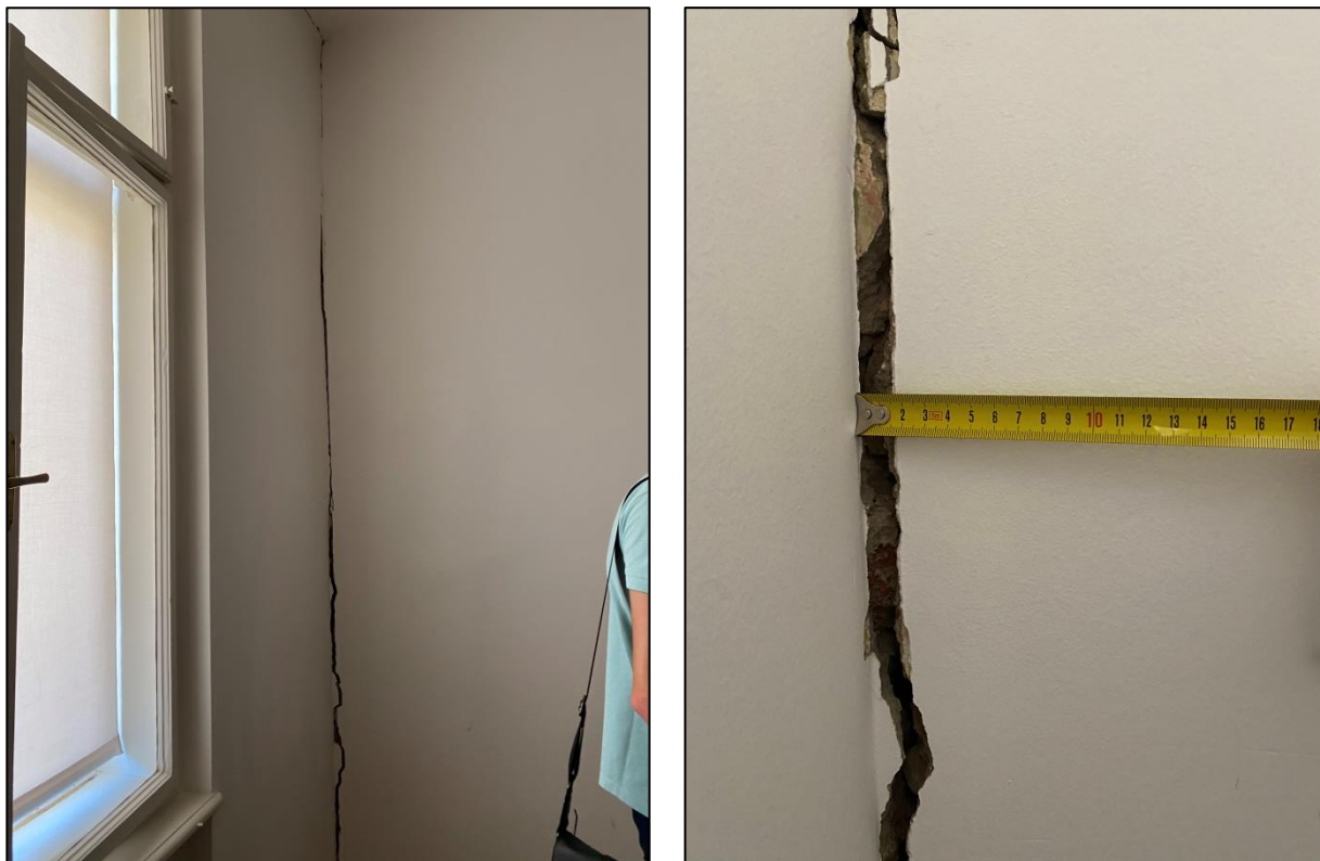
Slika 17 Odvajanje okomitih zidova trećeg kata desnog stana
