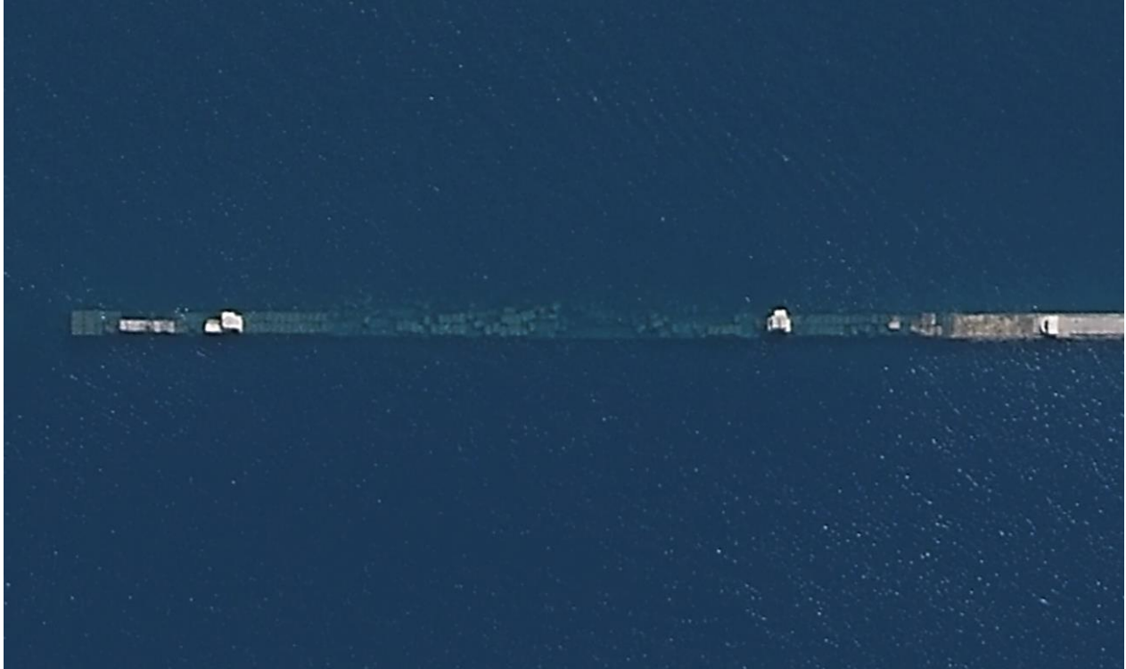
Slika 3. Oštećena dionica lukobrana Pula [2]
