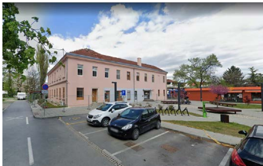
Slika 4 Južna strana objekta
