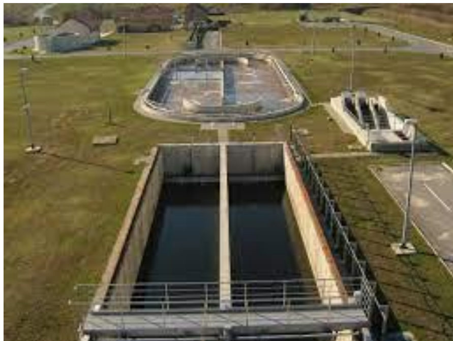
Slika 6. Bioeracijski reaktor i naknadni taložnik
