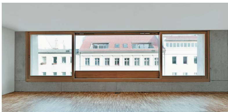
Slika 18 Unutrašnji prikaz prozora [56]
