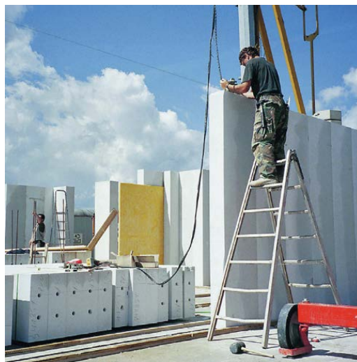
Slika 26 postavljanje visokih blokova [57]
