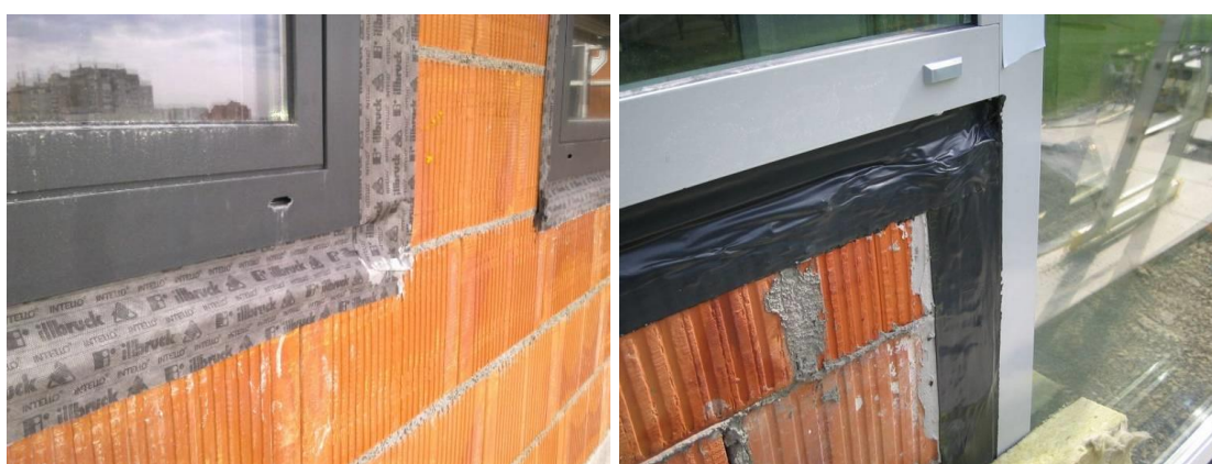
Slika 13. Detalj izvedbe vanjske britve ugradnjom vodonepropusne, a paropropusne folije
