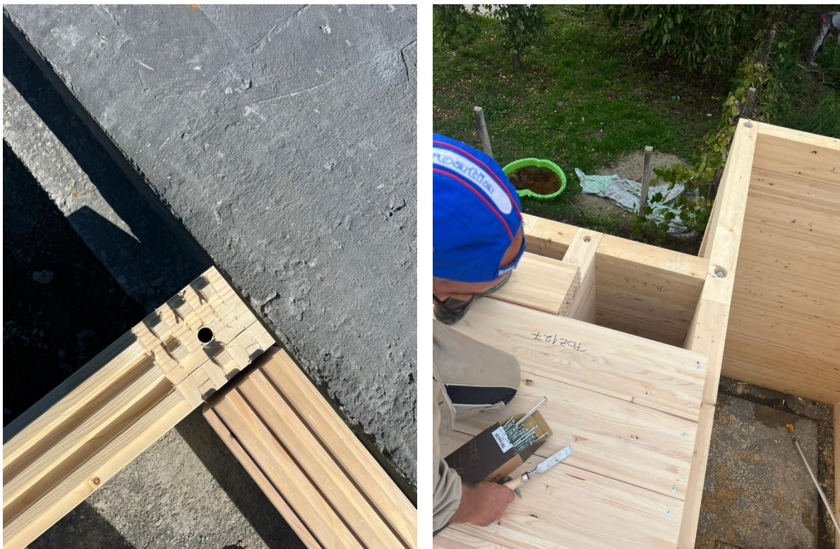
Slika 8. Prikaz tipova konstrukcijskih sklopova i načina spajanja drvenih prošupljenih elemenata
