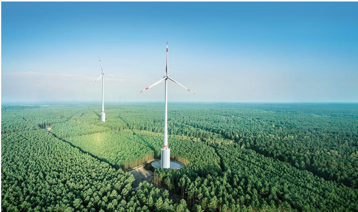
Slika 15. Dovršena vjetroturbina i puni rezervoar.
