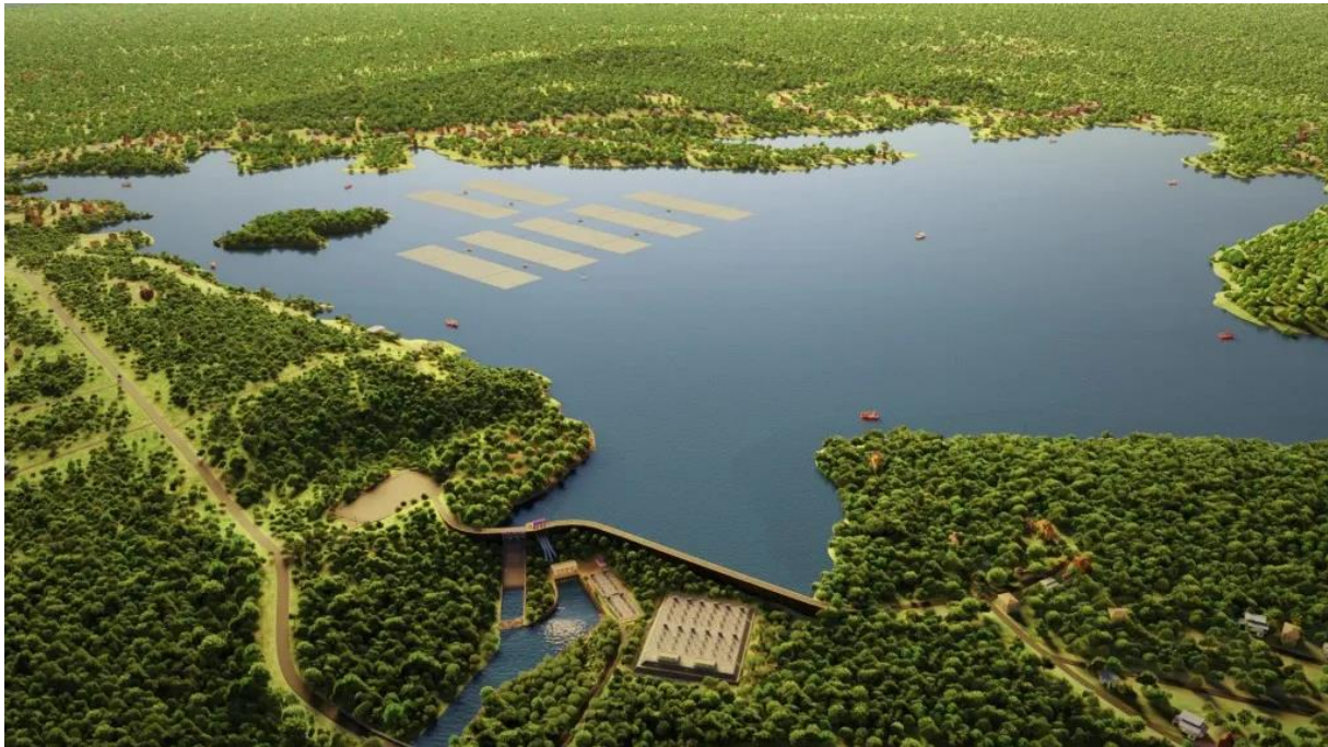
Slika 16. Hidro/solana elektrana Sirindhorn.
