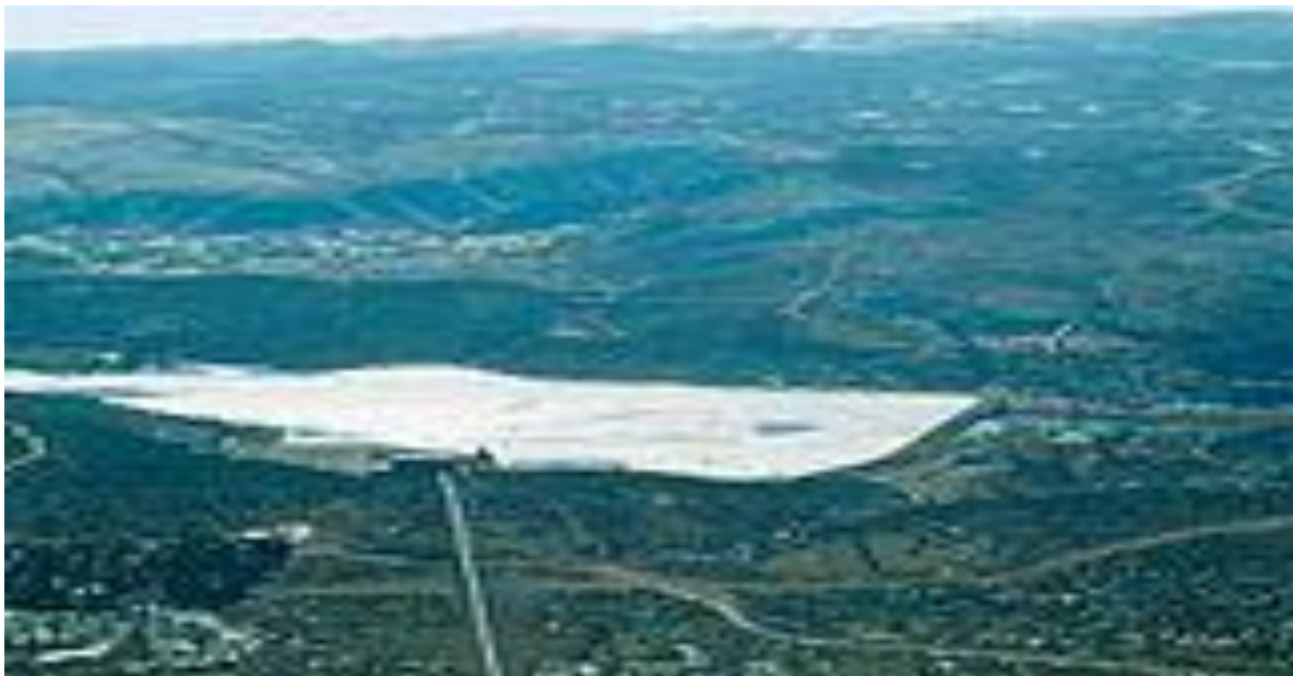
Slika 19. Panoramski pogled na RHE Velebit sa zasunske komore (vrh tlačnog cjevovoda) i pogled na zaledeno umjetno jezero Razovac u veljači 2012.
