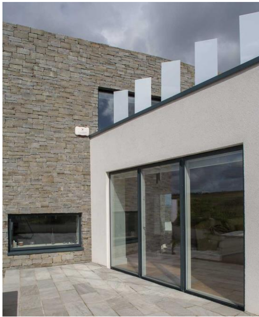
Slika 34. Trostruko ostakljeni prozori
