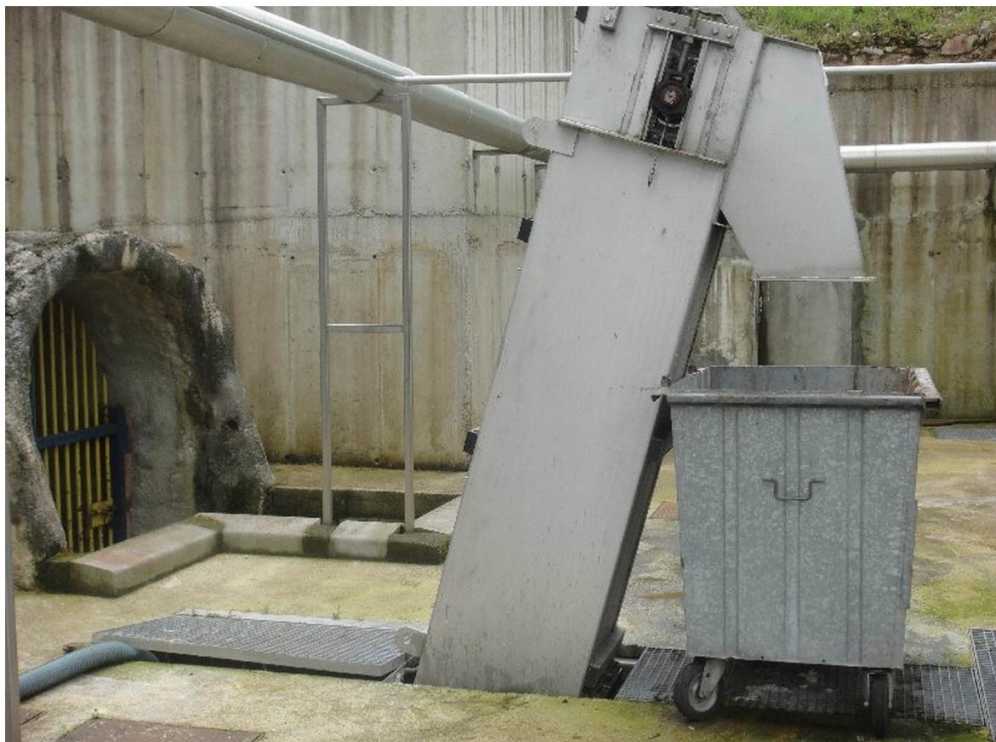
Slika 8 – Gruba rešetka s grabljama
