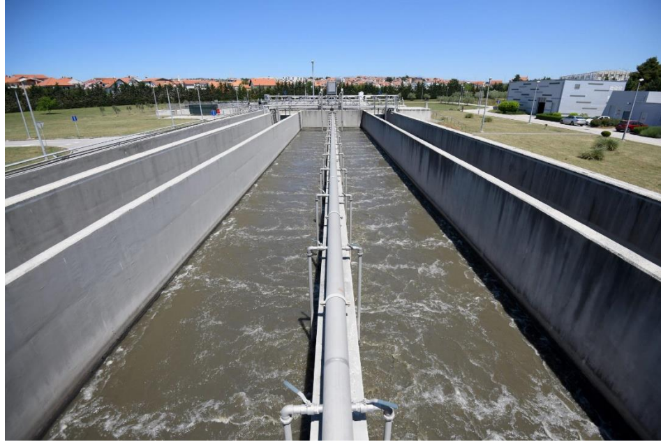
Slika 6 – Pjeskolov na uređaju za pročišćavanje u Zadru
