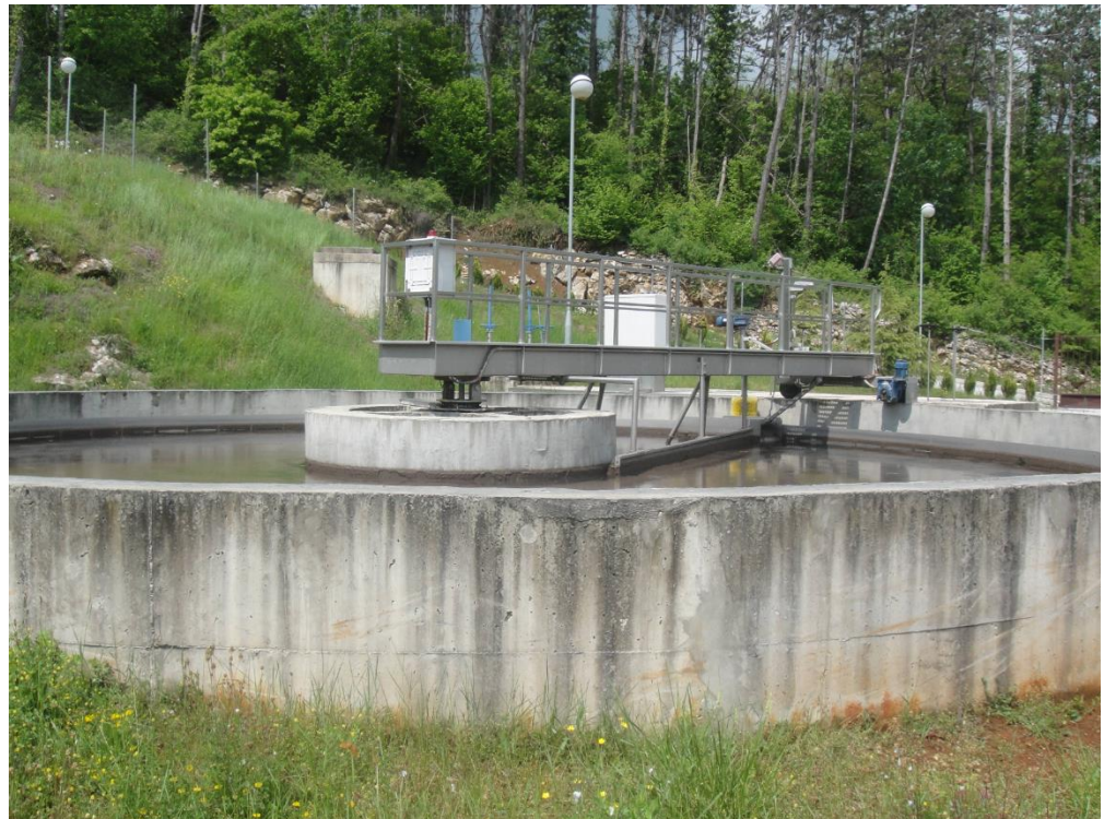
Slika 10 – Sekundarni taložnik
