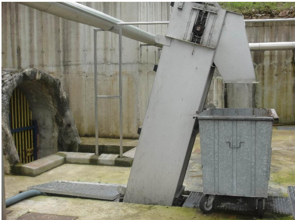
Slika 8 – Gruba rešetka s grabljama
