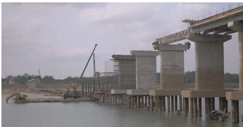
Slika 8 Duboko temeljenje na primjeru mosta
