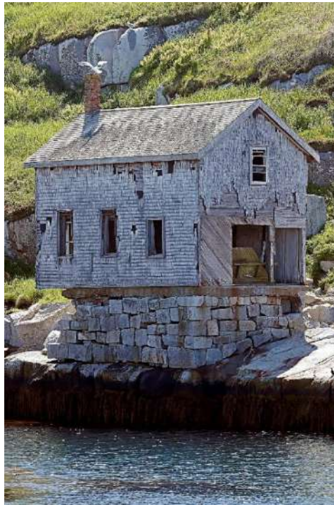
Slika 3. Temeljenje na kamenu
