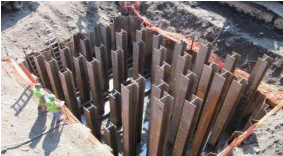
Slika 11 H-piloti zabijeni u tlo
