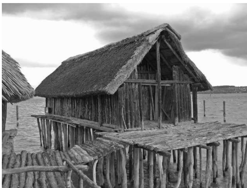
Slika 2 Temeljenje na drvenim stupovima
