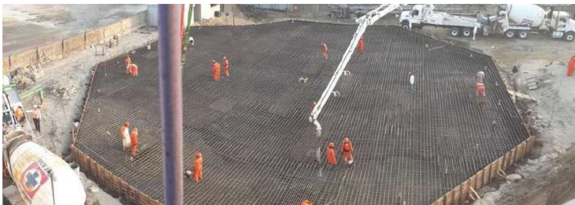
Slika 6 Betoniranje temeljne ploče
