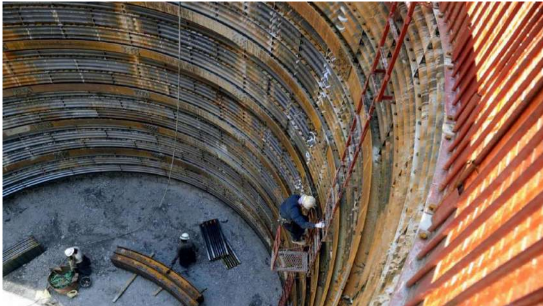
Slika 20 Pneumatski keson
