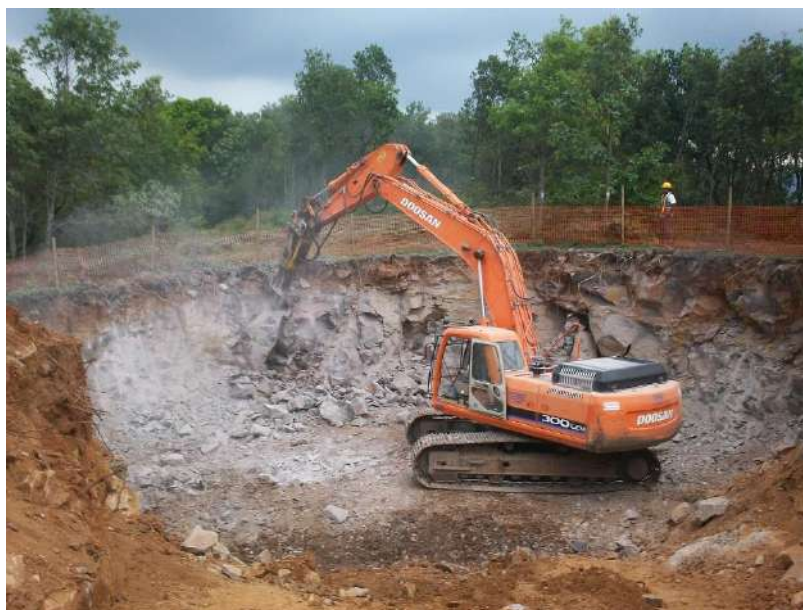
Slika 1 Iskop tla prije temeljenja
