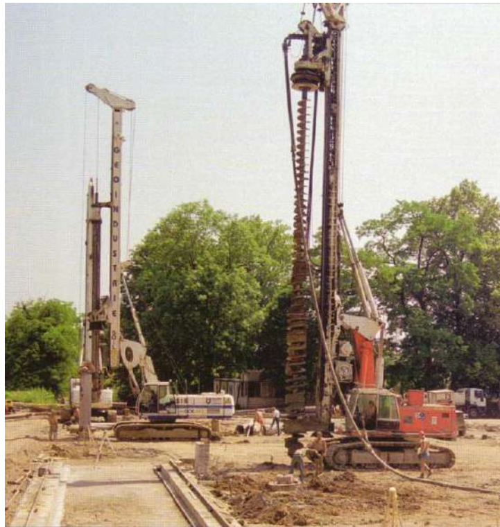
Slika 16 Izrada bušenih pilota
