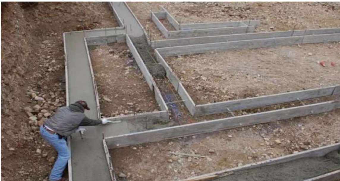
Slika 5 Izvedba temeljnih traka
