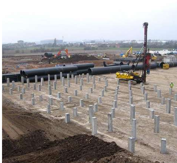
Slika 12 Betonski piloti na gradilištu
