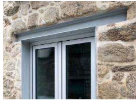
Slika 41. Izvedeni nadvoj od čeličnih traverzi
