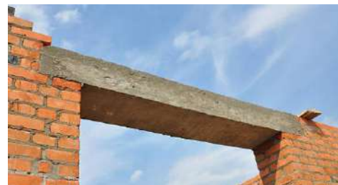
Slika 43. Izvedeni armiranobetonski nadvoj
