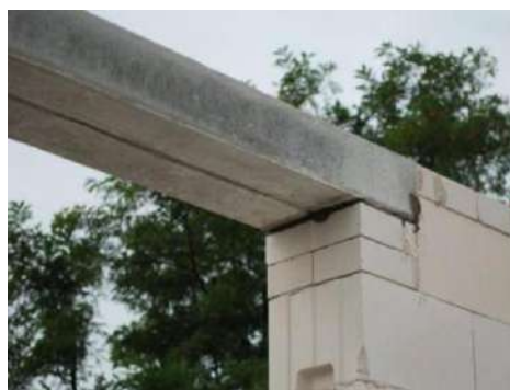
45. Izvedeni nadvoj od prefabriciranih armiranobetonskih elemenata
