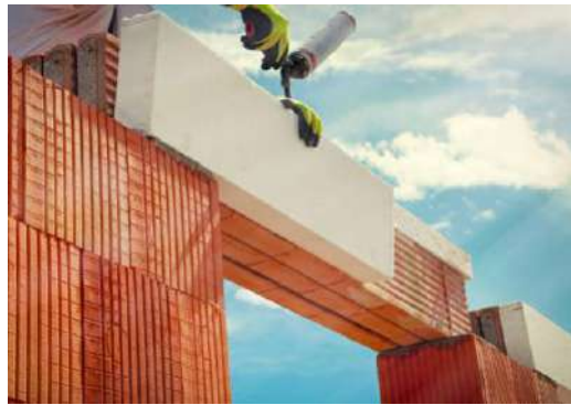
Slika 47. Izvedeni nadvoj od armirane tankostijene opeke
