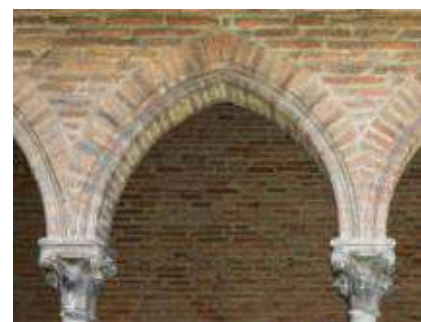
Slika 33. Izvedeni šiljasti luk od opeke zidan načinom s tri središta
