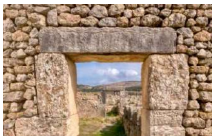
Slika 35. Izvedeni nadvoj od kamena
