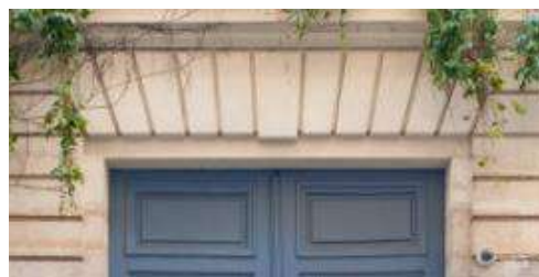
Slika 10. Izvedeni ravni luk od kamena
