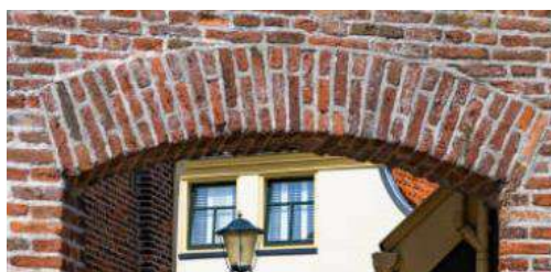
Slika 26. Izvedeni segmentni luk od opeke
