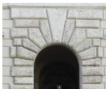
Slika 18. Izvedeni polukružni luk od kvakastih klesanaca
