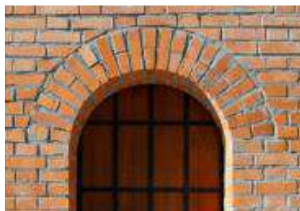
Slika 29. Izvedeni polukružni luk od opeke
